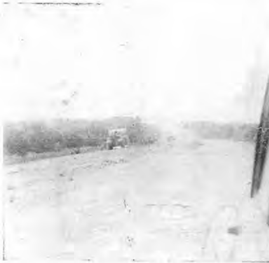
土煙をあげて走るスクレーパ (キャンサス州道路工事現場にて)
