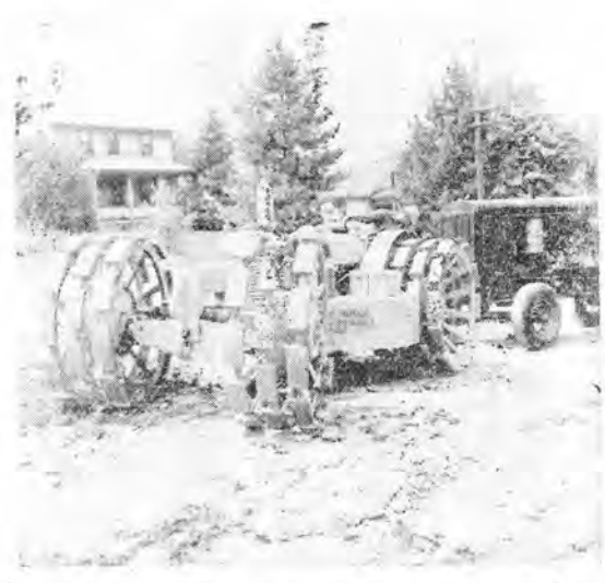
試験使用中の新型ローラ (オハイオターンパーク建設工事現場にて)
