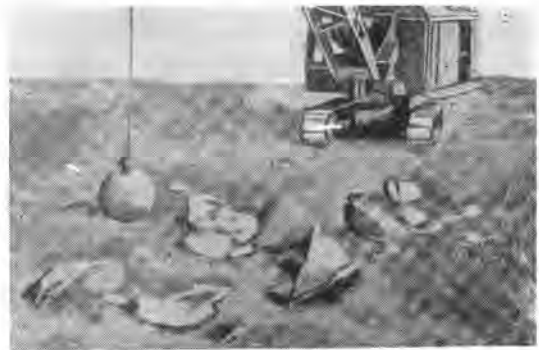
図-9 球落体による破碎後の景観
