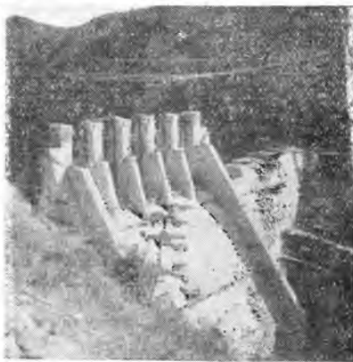
完成近い取水堰堤
