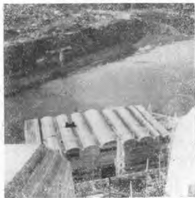
鉄管路より発電所を望む
