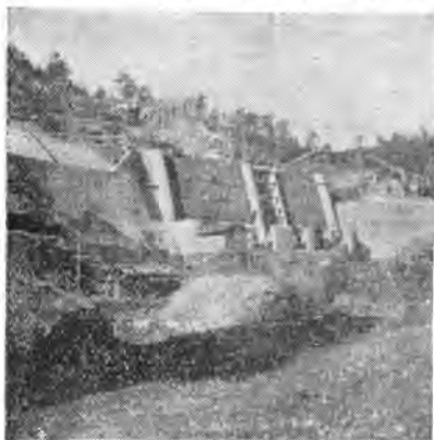
完成近い取入口(水門)
