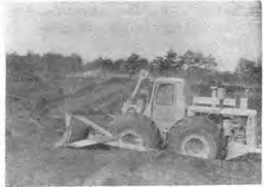
第 5 図 火山灰、礫の掘削作業
