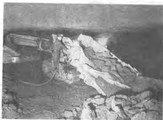
7尺加背の坑内に於て鉄鉄石積込の状況 (本現場の積込実績は毎分 12 吨)
