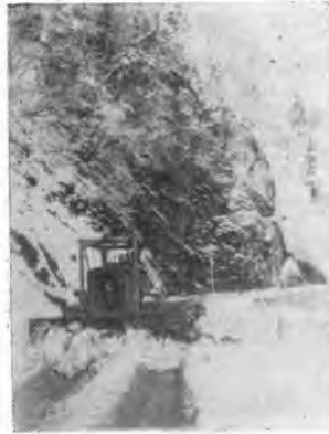
チャレンジャM-Ⅲにより 除雪作業中の福島歩危
