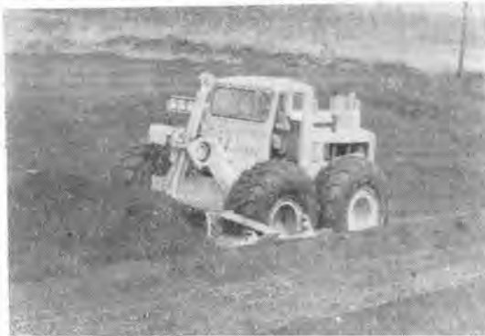
第 4 図 火山灰、礫の掘削作業 長手方向 ザ 使 用 実 績 表
