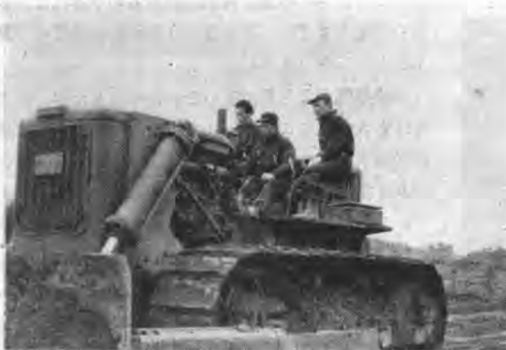
運転練習中のブルドーザ
