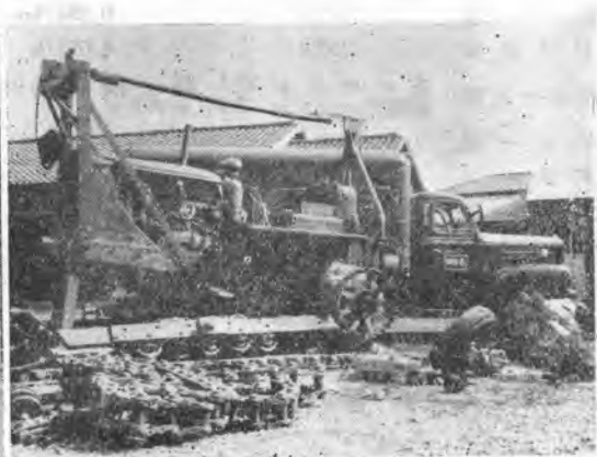
図 2 現場修理の状況 D-7 型ブルドーザ足廻り整備
