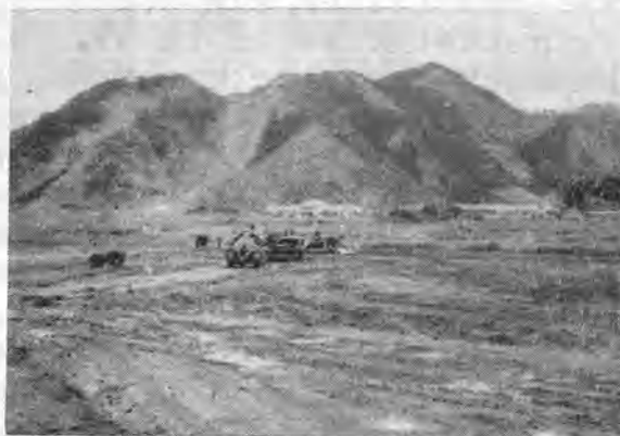
建設省土木研究所沼津支所遠景
