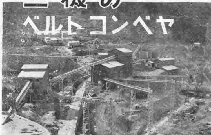
九州電力株式会社・上椎葉建設所殿 クラッシングプラントコンベヤ設備
