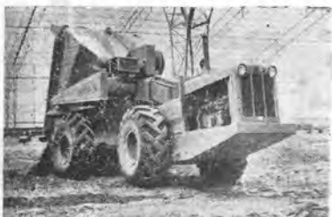
倉庫内部の地面を 1.5 米 上げる為砂をどつと卸す
