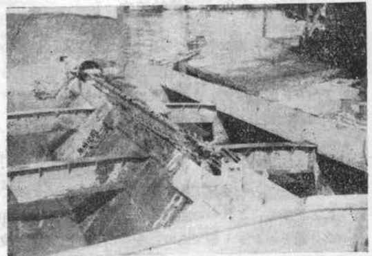
第 6 図 泥扉開閉用ローラ装置
