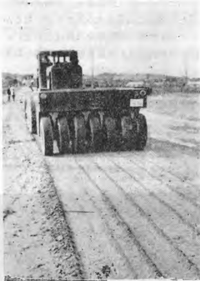
タイヤローラによる転圧作業
