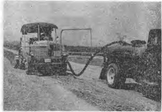
シーマンミキサと撒水車による協同作業 グレーダによって牽引されている。
