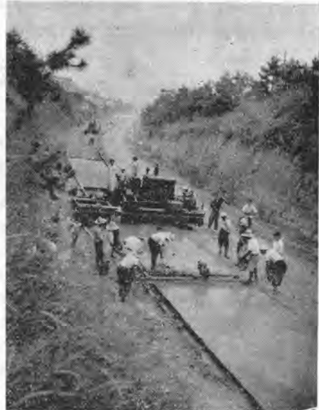
フィニッシャ仕上後、更に表面パイブレータ (簡易フィニッシャ) を用いている状況
