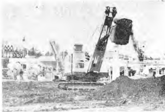
実演中のパワーショベル (0.5m 3 )
