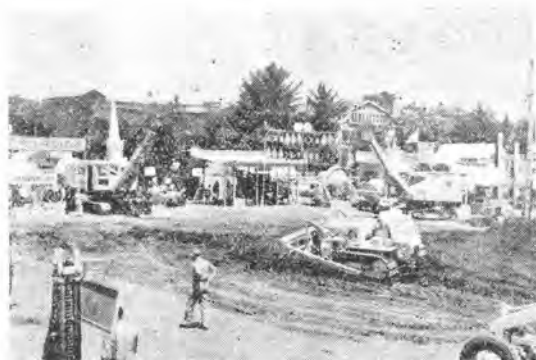
実演場全景 (油圧式 10t ブルドーザ)
