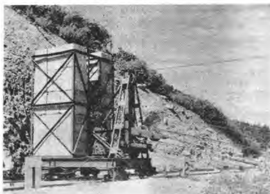
4.5t ケーブルクレーン走行路の標識 (10m間隔で照明灯付)
