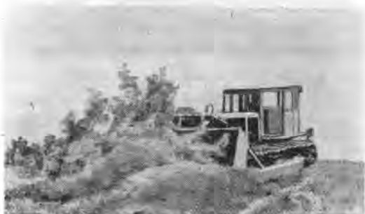
図-7 掘削用歯付ブルドーザ デー 275 型、途上のしげみと切株とを開墾しているところ
