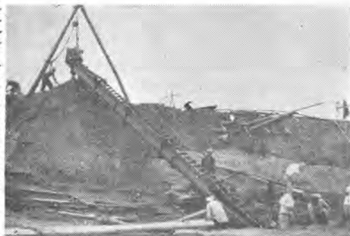
愛知県半田港地区の災害復旧工事 (岡建設株式会社施工)
