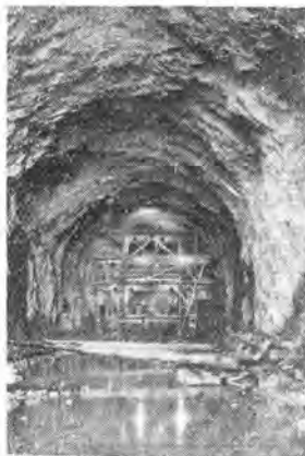
写真—2 ジャンボ合車による穿孔作業
