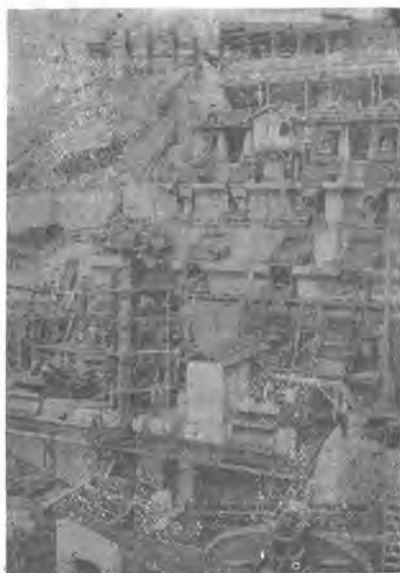
丸山ダム骨材破碎篩分装置
