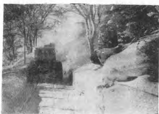
除雪後の状況 (水上附近)
