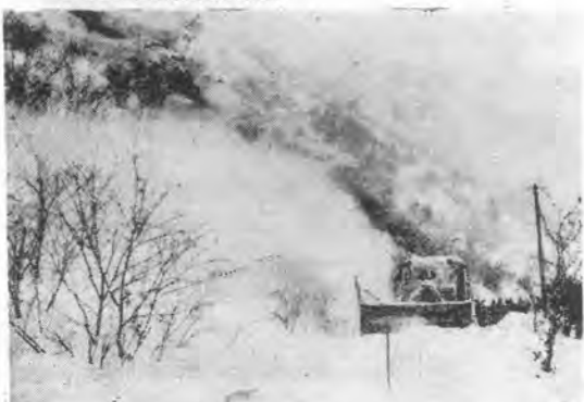
除雪作業状況
