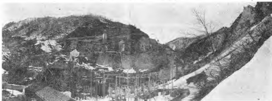
須田貝ダム工事現場全景
