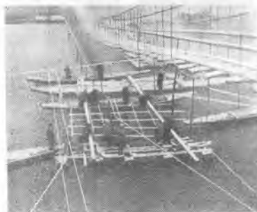
写真一五 古軌条組立状況
