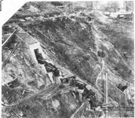
写真-8 機械組立中の第二工場 (右下に見えるのは第三工場)
