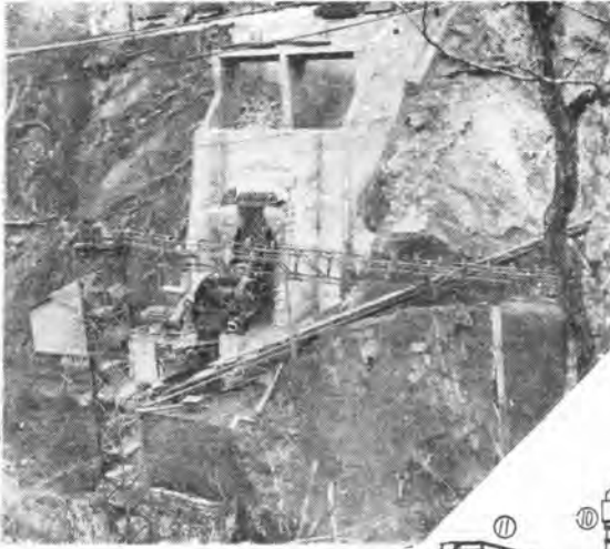
写真-7 機械組立中の第一工場 (前方に見えるのは大砕破(砕石) 用コンベヤーとロックダラーである)
