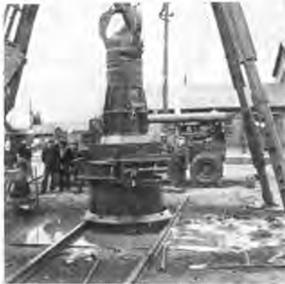
第6図 川崎における作業の実況
