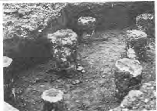
写真一四 プレバクト・基礎杭
