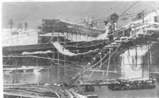
写真一七 注入景
