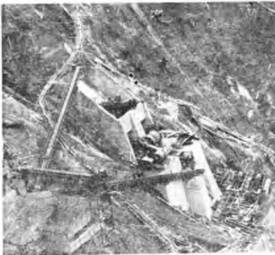
写真-9 機械組立中の第三工場
