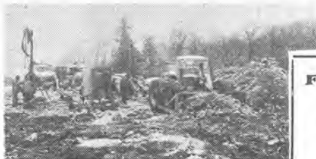
此の 1,700 万弗の国道建設工事に上図のターナトラクターが、パワー・ショベル周りの取り片付けをしたり、岩石集積所が崩れない様になり活躍しています。
