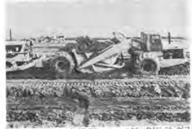
パリ—リール間国道建設—フランス
