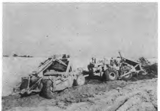
第7図 バンキング捨土作業
