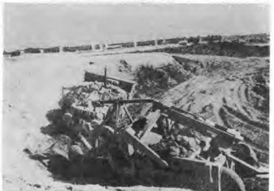
第8図 バンキング捨土作業
