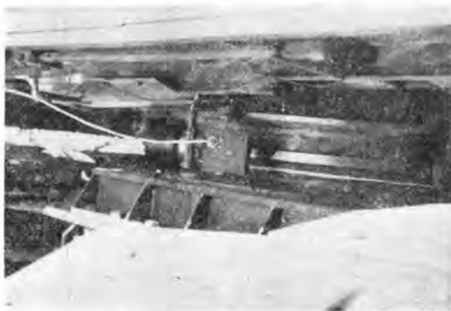
写真-6 旋回角度計発信器
