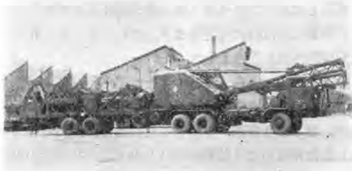
第5図 アタッチメントを搭載したトレーラ を牽引走行中のトラッククレーン
