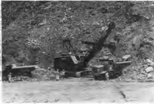
Fig. 14 マリオン 111-M による捲込試験 (旋回角度約 90 度)
