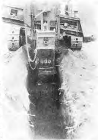
写真-4 溝の前方より（手前）にあるのがスクレーパー)
