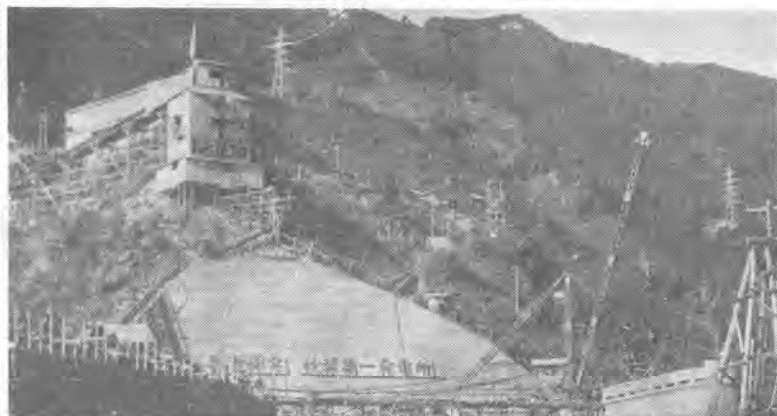
佐藤工業KK殿納入 28 号 -2 半自動式バッチャープラント 6 ton ガイデリッククレーン
