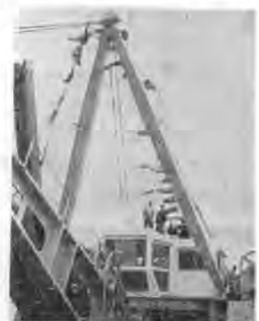
写真-2 Aフレームと操縦室
