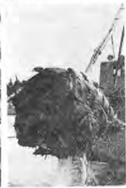
写真-3 粘土の付着状況
