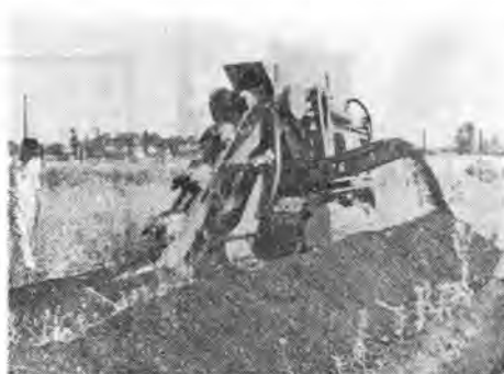
写真-2 性能試験中の NTK-450 型デイッチャ
