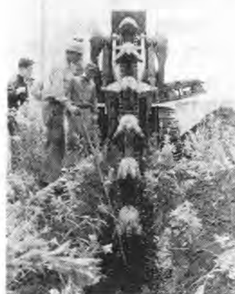
写真-3 性能試験中の NTK-450 デイッチャ
