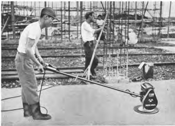
某ビルのコンクリート仕上作業
