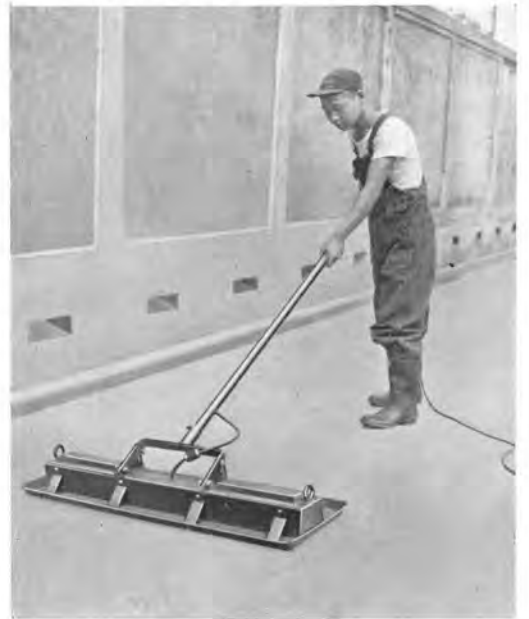
某運動場のコンクリート仕上作業
