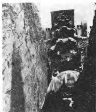
写真—4 北海道新野幌重粘土 地帯排水溝側面切削状態
