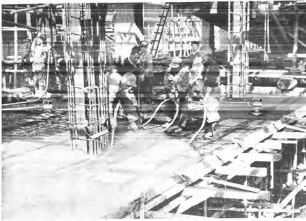
某ダムのコンクリート打設作業
