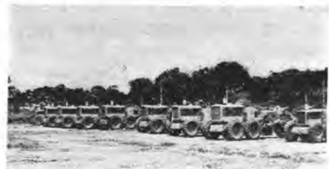
写真—5 南ヴェトナム、サイゴン市郊外公共事業省土木局モータープールに集結中のキャタピラー社製モーターグレーダ
