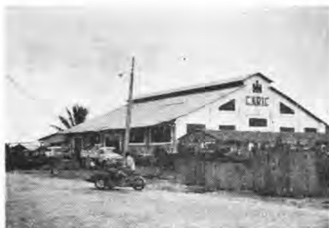
写真-6 南ヴェトナム、サイゴン港附近に建設中のインターナショナルハーベスター社のサービス工場
