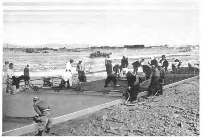
某航空基地のコンクリート打設作業
