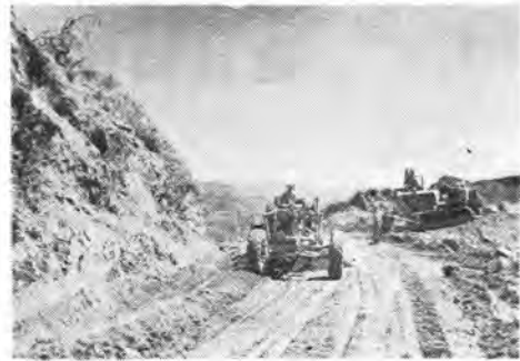
写真—2 フィリピン バギオ市東方約 30 km の地点で電源開発道路を建設中のキャタピラー社製 No.12 モーターグレーダと D8 ブルドーザ
