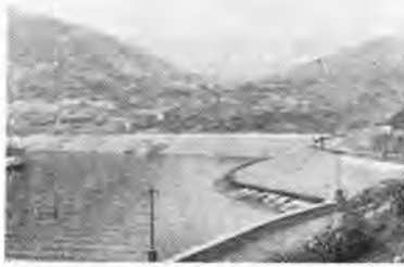
写真-7 北京の近くの永定河官庁のアーサダム
