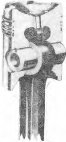
写真-5 Caterpillar D 337 型エンジンピストン
