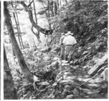
写真-2 新設道路センター 岩石地帯
