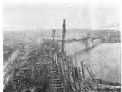
写真-10 重慶近く建設中の獅子灘のロックフィルダム
