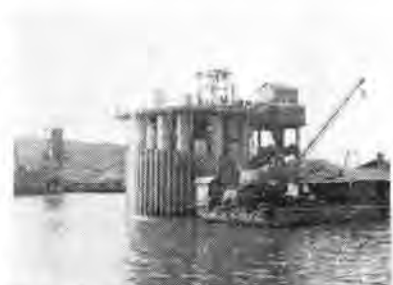
写真—4 長江に架設中の武漢大鉄橋のピーヤ
