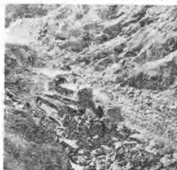
写真-6 ドーザールータによる作業
