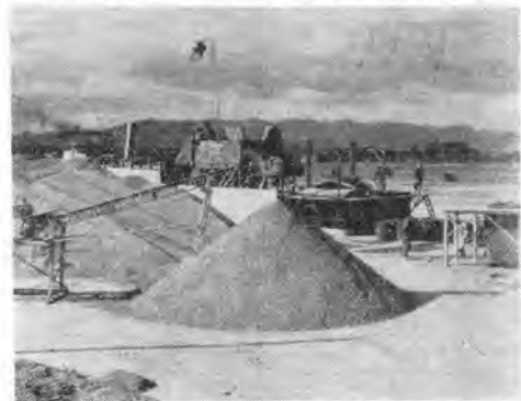
写真-2 バーバーグリーンプラントおよび骨材集積
