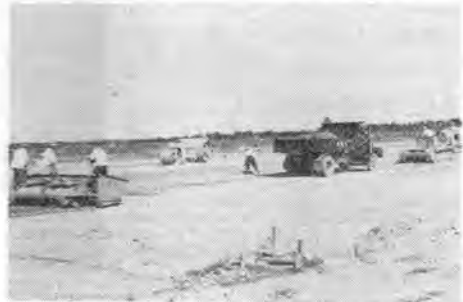
写真-8c スプレッタ砕石敷均し作業
