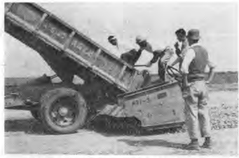
写真-8b スプレッタ砕石敷均し作業
