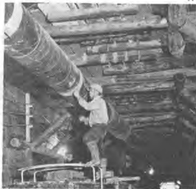
隧道用エアーダクト施工の実況
