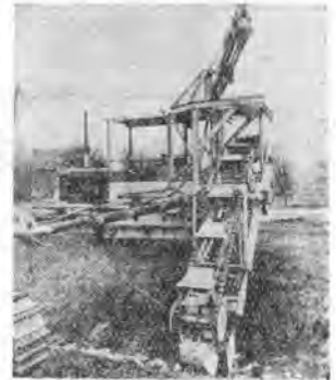
写真-2 ピアレスドレッジャの掘削状況
