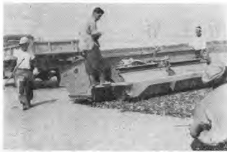
写真-8a スプレッタ砕石敷均し作業
