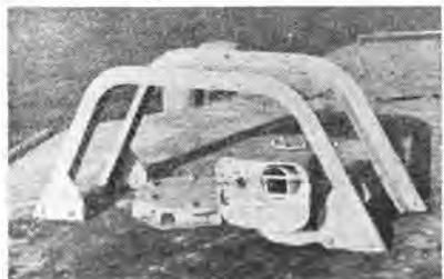
写真-2 空気抜孔およびバルブ開閉標示灯 (開の赤)
