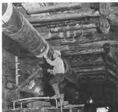
隧道用エアダクト施工の実況 (福島県只見線滝沢隧道工事) 鹿島建設施工
