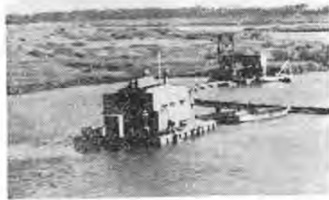
写真-1 建設省利根川下流工事事務所で運転中の発電船 電動機 200 IP, 発電機 250 k.V.A.
