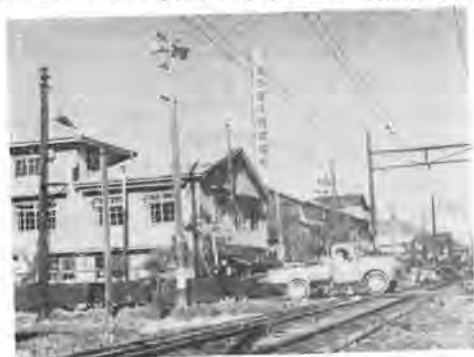
写真—1 事務所および組立工場の一部外観
