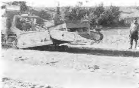
写真-2 スタビライザ (アウトバーン)
