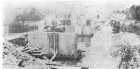
写真-8 橋梁下部工事 (インディアナ・トルロード)
