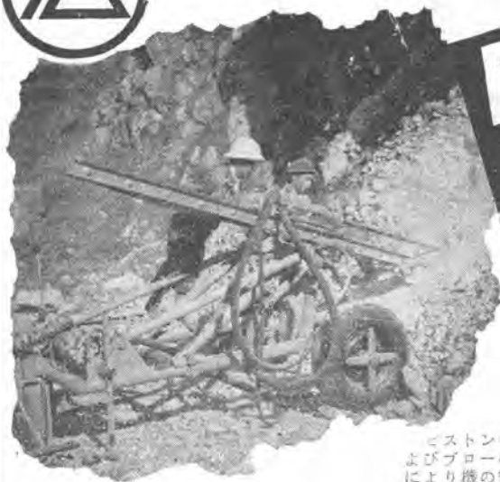
敦賀セメント K.K. 採石場に於ける MW-8 型ワゴンドリル
