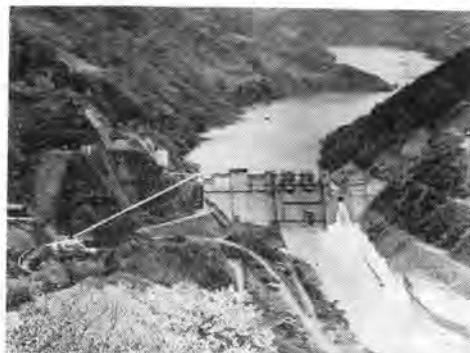
写真-1 鍮畑ダム工事現場全景
