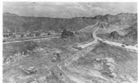
写真—4 会場入口正面道路建設大パノラマの一部
