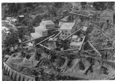
写-2 八久和ダム骨材製造場全景
