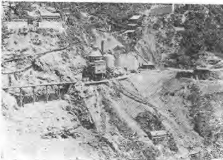
写真-1 仮設備（ダム右岸から仮設備を見る）
