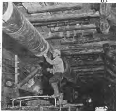
隧道用エアーダクト施工の実況
