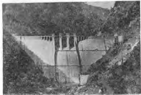
写真-2 ダム下流面
