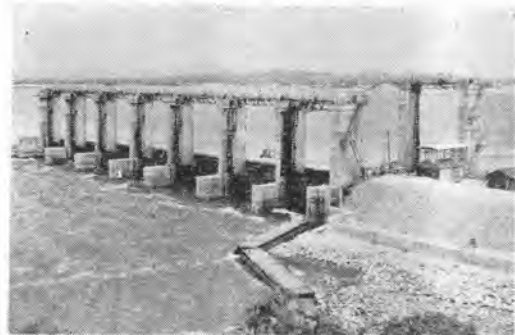
写真—7 同上竣功後
