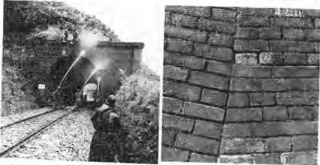
写真-3 (左) ウォータージェット洗浄状況 (右) 洗浄済の煉瓦
