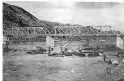
写真-3 有田川におけるショベル作業
