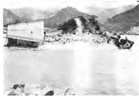
写真-2 転倒による捨込み作業
