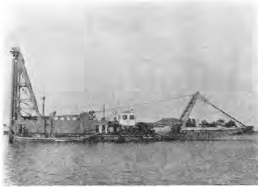
写真-3 1,000 HP 浚渫船
