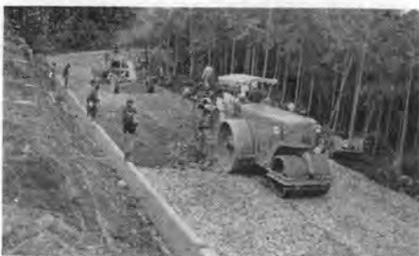
写真-16 上層碎石 (35~50 mm 級) 敷均し
