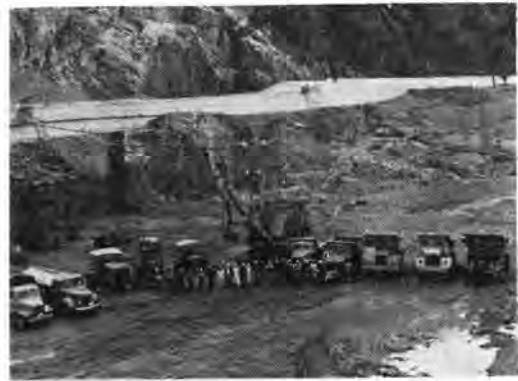
写真-2 ダム付近の重機群
