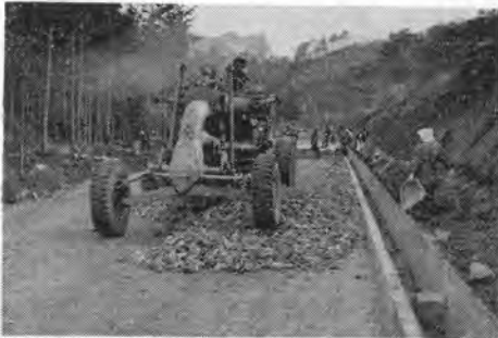
写真-15 下層碎石 (70 mm 級) 敷均し グレーダのほかに労務者 12~18 名で 3,000~4,000 m 2 の敷布 は可能である。
