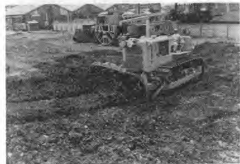
写真-7 ブルドーザの試運転場
