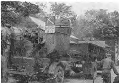
写真-6 パッチモビール作業時の状態
