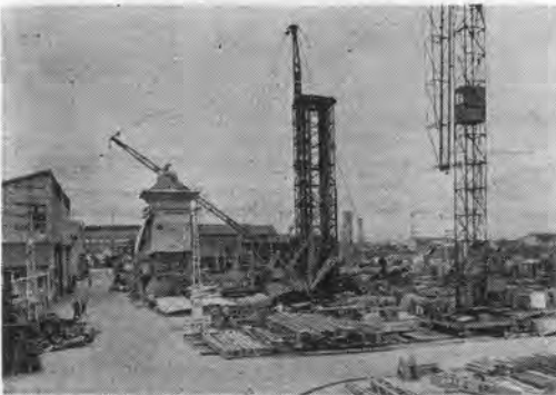
写真—5 屋外機械置場
