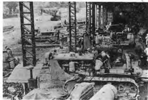
写真-4 ブルドーザ修理工場作業状況
