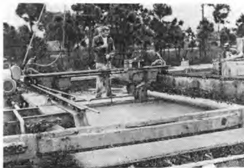
写真-7 作業中のフィニッシャ
