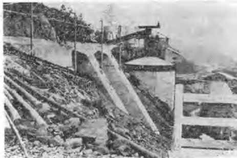
写真-4 再締分工場おびび 112切×4 バッチャプラント
