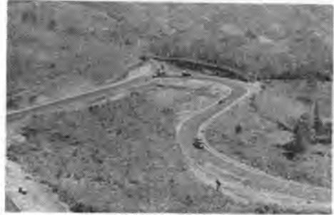
写真-2 No. 360 付近完成直前
