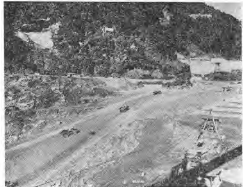
写真—2 ダム掘削 ダンプ昇降路傾斜状況 (ダンプはユークリッド 15t ダンプ)
