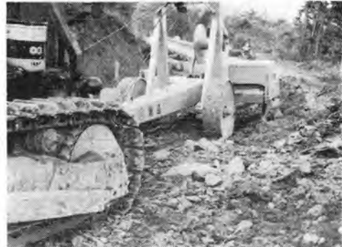
写真-10 ルータによる路面切下げ
