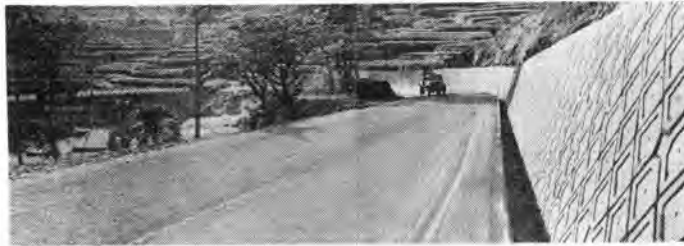
写真-23 同上 完成後
