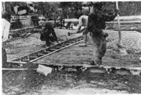
写真-6 エキスパンションジョイント
