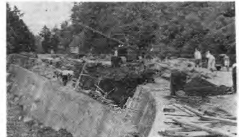
写真-11 コンクリート擁壁上のKブロック積み
