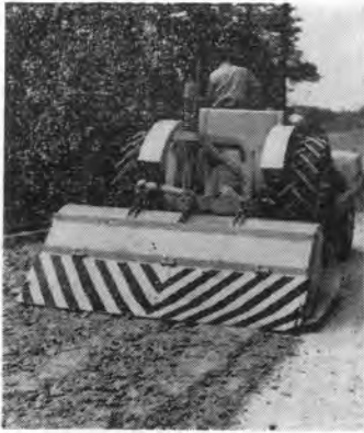
写真-13 シーマンミキサ 準備を良くすれば 2,000~2,500 m 2 /h の 土壌改良は容易である。
