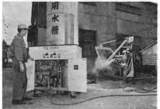
写真—9 スチームクリーナによる洗車作業
