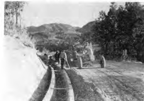
写真-12 路床仕上げ
