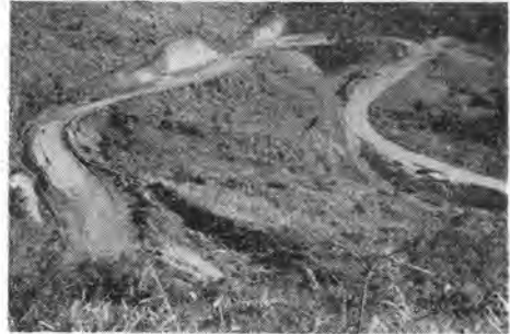
写真-1 No. 360 付近施工前
