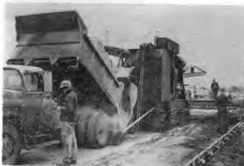
写真-4 バッチトラックからペーバーへの材料投入
