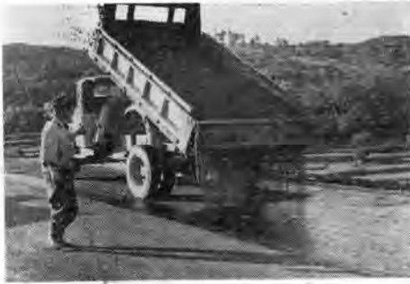
写真-21 ダンプカーによるチップ撒布 (シールコート工)
