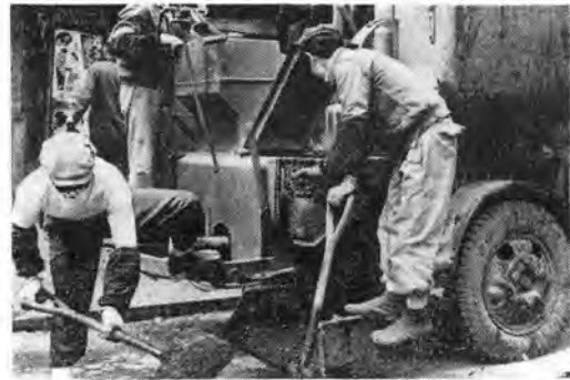
写真-7 パッチモビールから合材の出でるところ
