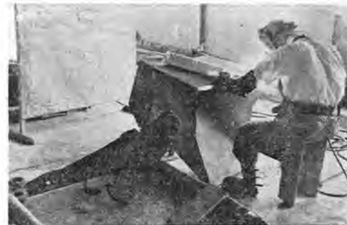
写真-4 ロッカーショベルバケットの溶接
