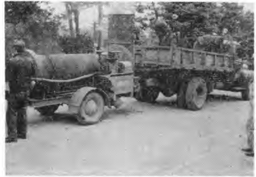
写真-4 トラックから骨材をドライヤに投入するところ
