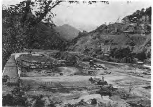
写真—2 コンクリート打設中のダム地点 写真左仮排水路、右パッチャプラントおよびケーブルクレーン
