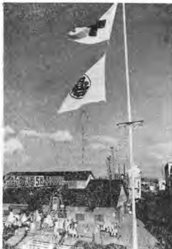
写真—2 東京機械工場 中央道路付近
