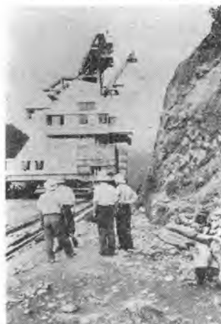
写真-6 25 t ケーブルクレーン エンジンタワー
