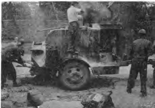
写真-3 モート・パッチャから合材の出でるところ
