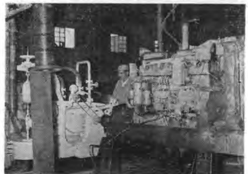
写真—10 エンジンの台上試験
