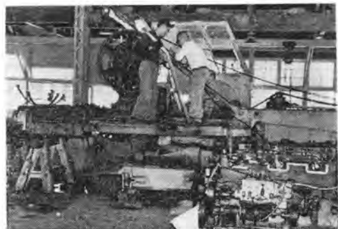
写真-3 ショベル分解修理
