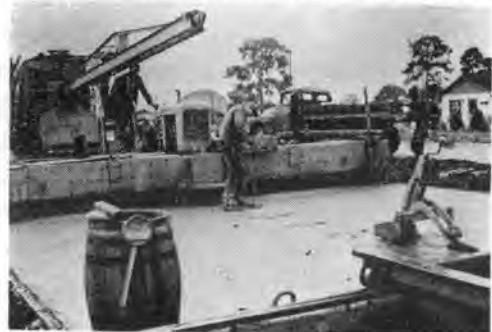
写真-5 トランスバースジョイントの埋込み
