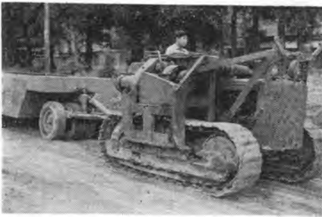
写真-14 タイヤローラによる転圧
