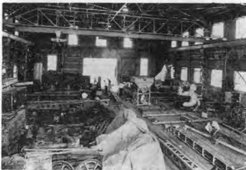
写真—7 鍛造製缶工場内部
