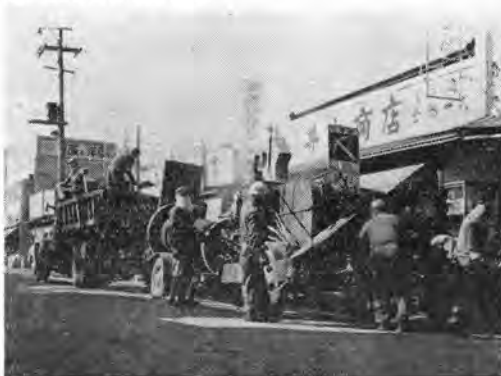
写真一1 ドライヤおよびモートパッチャ作業時の状態(その1)
