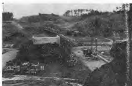
写真—1 川上町付近で集団化して稼働中のブルドーザ、キャリオールの一団 (右側サンドパイルドライバ)
