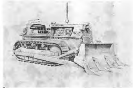
写真-3 Caterpillar ジャイロドーザ (No.7G)
