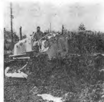
写真-4 含水比の非常に高いロームにいたむ 18t ブルドーザ
