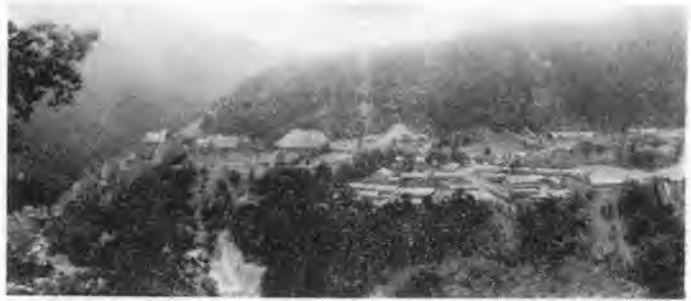
写真-1 有峯ダム工事場全景左端はダム、右は骨材破碎ふるい分場
