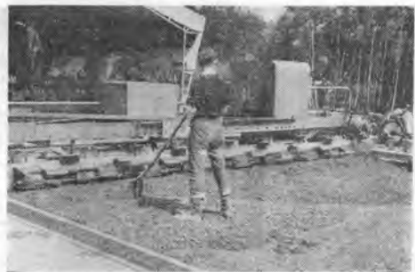
写真-11 ドイツアウトバーンのコンクリート工場の敷均し ハンブルグ付近にて
