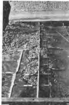
写真-2 膨脹目地の施工図
