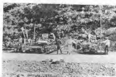
【写真-5】ロードフィニッシャ 右・渡辺式、左・油谷式
