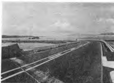
写真一四 嫁ガ島跨線橋から起点側 (第2工区)を望む
