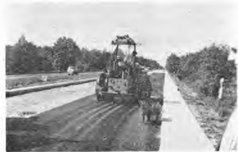
写真-8 舗装仕上のタイヤローラ アウトバーン 補修工事 フランクフルト付近
