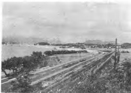
写真一五 第2工区遠望(起点側より)
