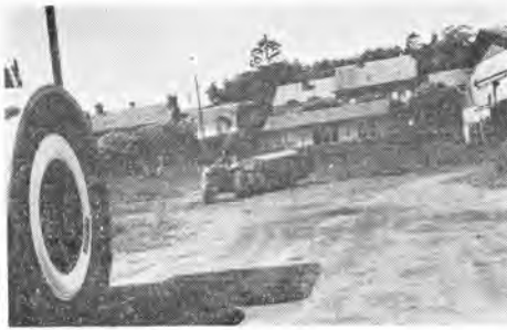
写真-4 タイヤ挟入のロードローラ (左側に見える車輪)
