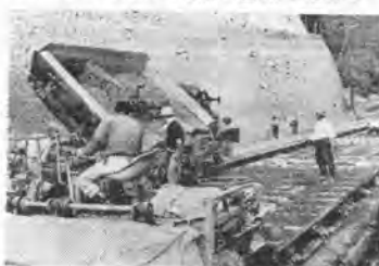
写真-4 ダンプトラックからコンクリートが排出される様子
