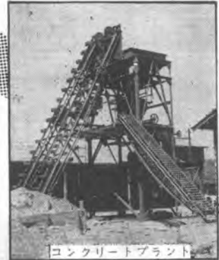
コンクリートプラント
