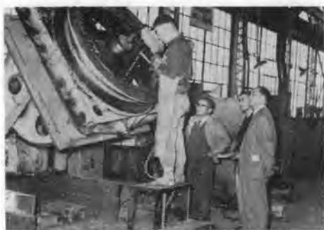
写真-1 溶接用ポジショナによる0.6m 3 ショベルの旋回歯車の肉盛作業
