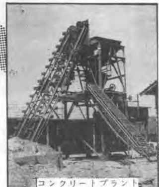
コンクリートプラント
