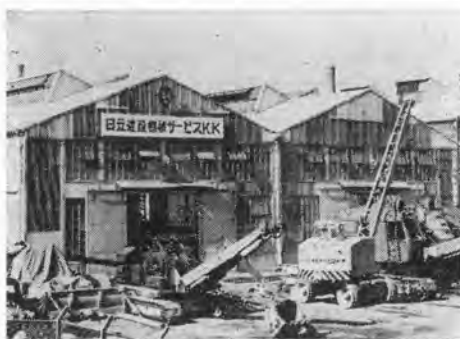
写真-2 屋外より日建工場を望む
