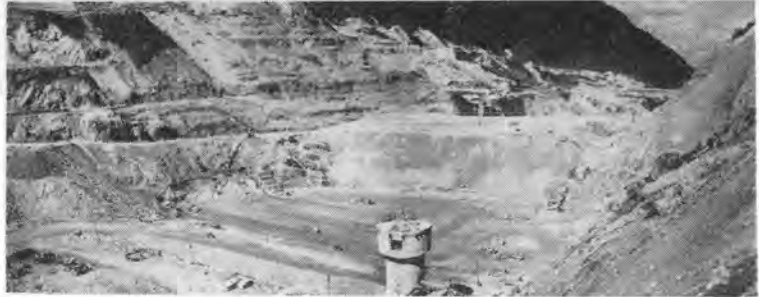
写真-1 最近におけるダム工事状況
