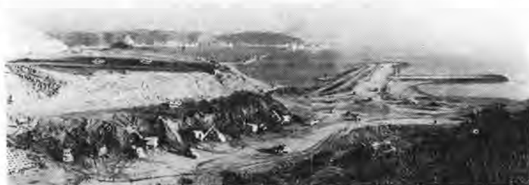
写真-2 埋立工事に活躍する機械群
