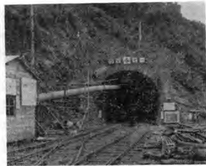
写真-14 第4工区今庄方坑口
