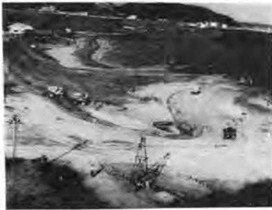
写真-3 埋立現場の状況
