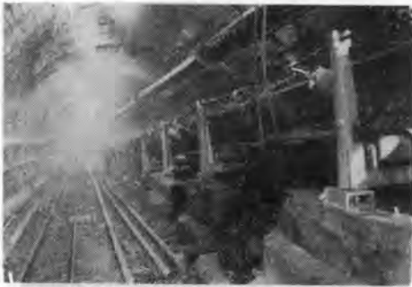
写真-9 斜坑に取付けられたロープサスペンションコンベヤ，ロープにつり下げたキャリヤローラが見える
