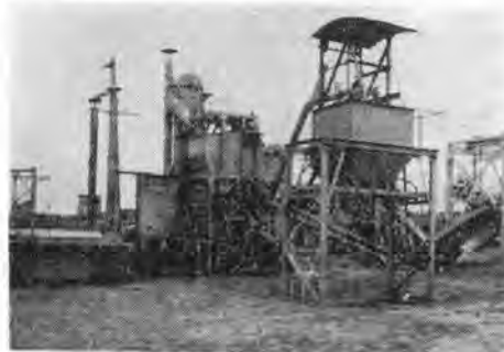
写真-1 15~20 t/h ポータブルアスファルトプラント
