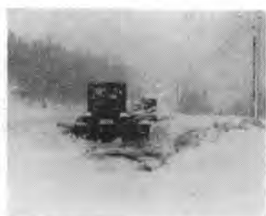
写真-3 除雪状況
