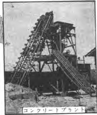
コンクリートプラント
