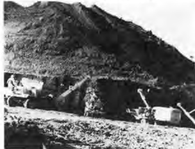
写真-4 ショベル・ダンプの組合わせ作業状況
