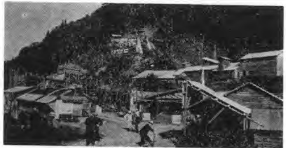
写真-11 第3工区全景
