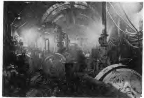
写真-10 坑内排水ポンプ室
