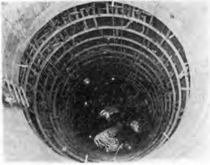
写真-12 立坑を上部から望む
