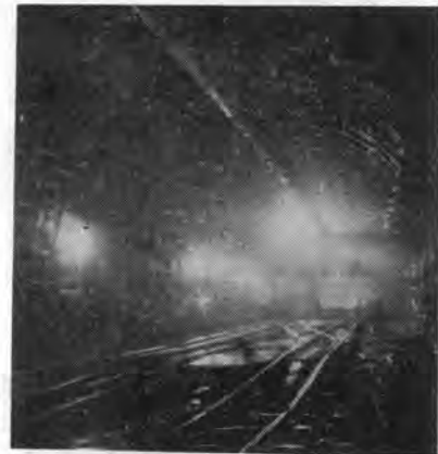
写真-4 掘削完了した坑内
