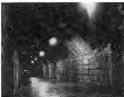
写真-1 ずい道照明(巻立部)
