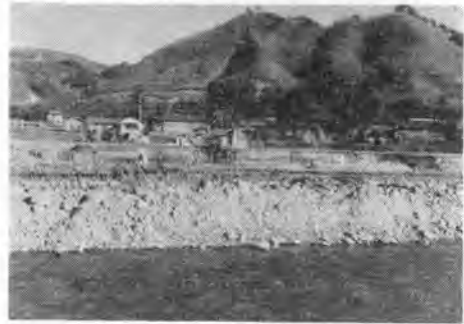
写真-3 牧の郷地区の氾濫し状況
