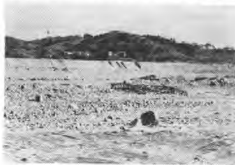
写真-2 中島地区の仮締切状況
