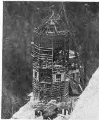
写真-2 組立中のバッチャープラント (手前が112S×4, 先方が56S×4)
