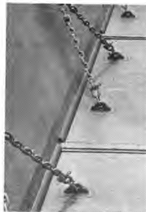
写真-4 改造前の泥倉扉
