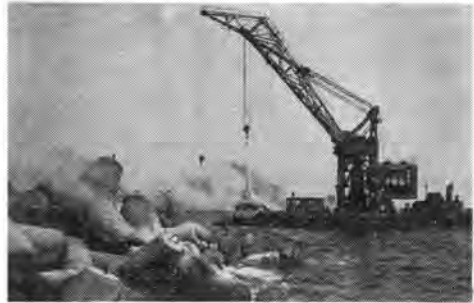
写真-4 テトラポッド据付状況
