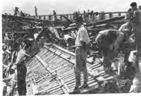
写真-5 永代橋上流部の状況
