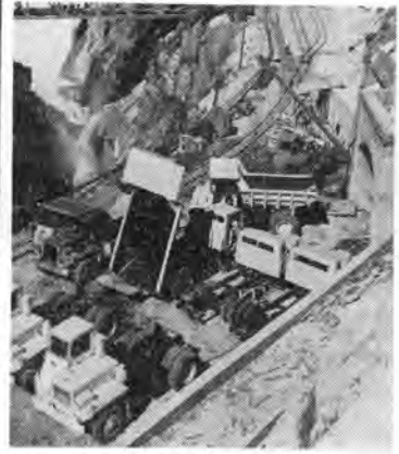
写真-3 現場で組立中のダンブトラック
