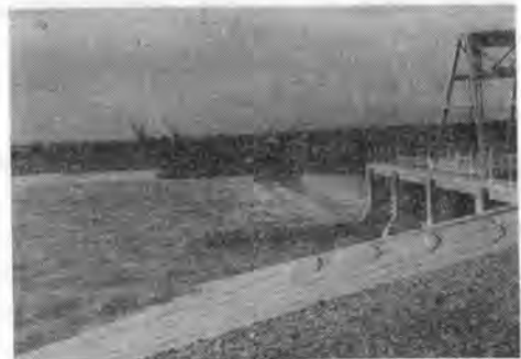
写真-5 ヘルマンド河の取水堰堤
