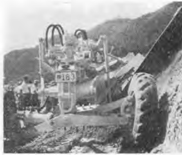
写真-2 バンクカット作業
