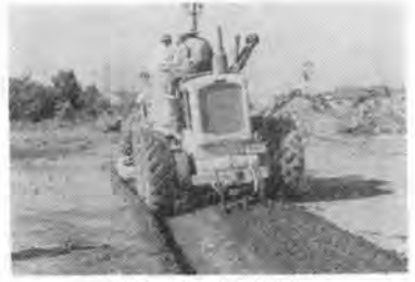
写真-3 溝掘り作業
