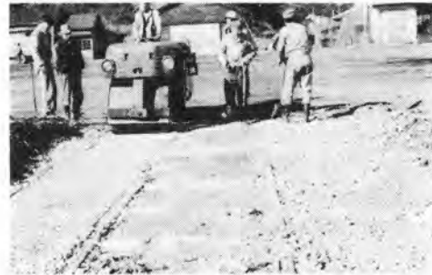
写真—8 振動ローラの締固め試験
