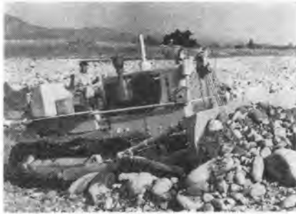
写真-5 渡良瀬川上流にて水路掘削作業に活躍中の BE 型アングルドーザ
