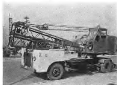
写真-2 走行姿勢の日立 F03 トラッククレーン
