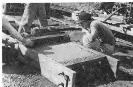
写真-9 模型フィニッシャによるコンクリートの作動締固め試験
