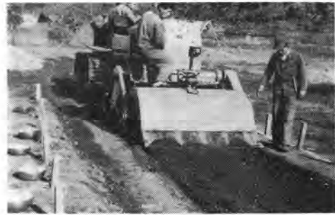
写真—7 スタビライザ粉碎混合能力の試験
