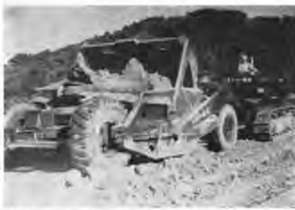
写真-1 日開FA8L型スクレーパの稼働状況
