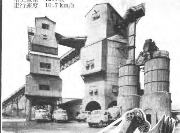
生コン用 バッチャープラント 56S ミキサー2基
