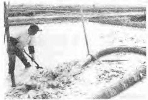
写真-4 泥水吐出口
