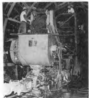
図-5 石川島 20A によるコンクリート打設
