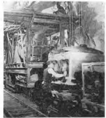
図-4 コンクリートジャンボに骨材のつり込み
