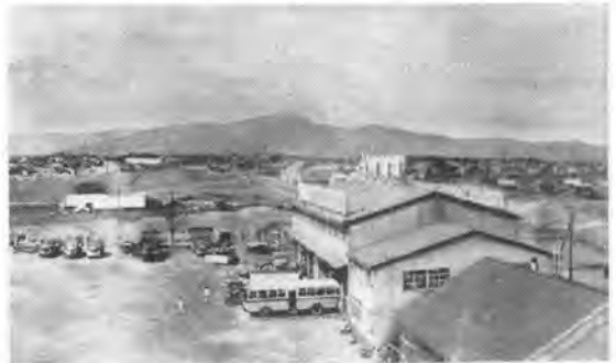
写真-1 北海道ふそう自動車整備工場
