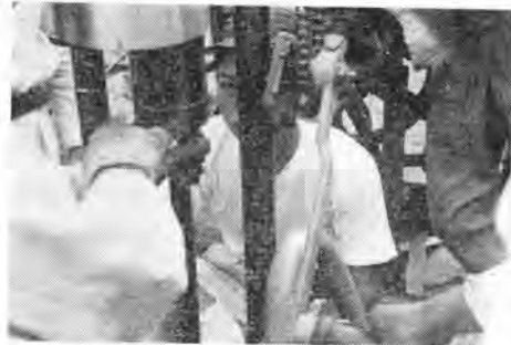
写真-3 ロッド押し込み状況
