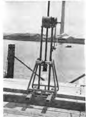
写真-1 2tアバラタス設置状況
