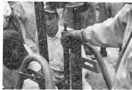
写真-2 ロッド押し込み状況
