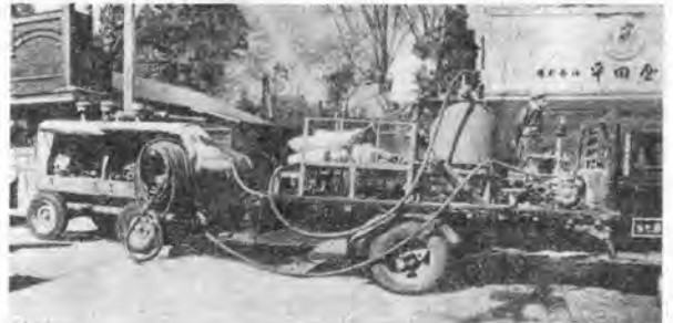
写真-4 Sub-sealing 工法—左からポータブルコンプレッサ、トラック上のモルタルミキサ、グラウトポンプ
