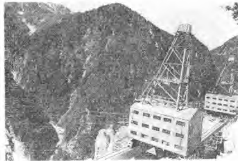
写真-1 エンジンタワー全景
