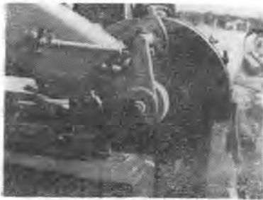
写真-1 カーボランダムブレードによるコンクリート切断
