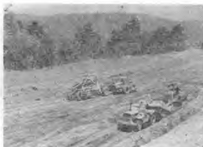
写真-5 DW-15 モータースクレーパーとタイヤドーザけん引スクレーパーの稼働状況
