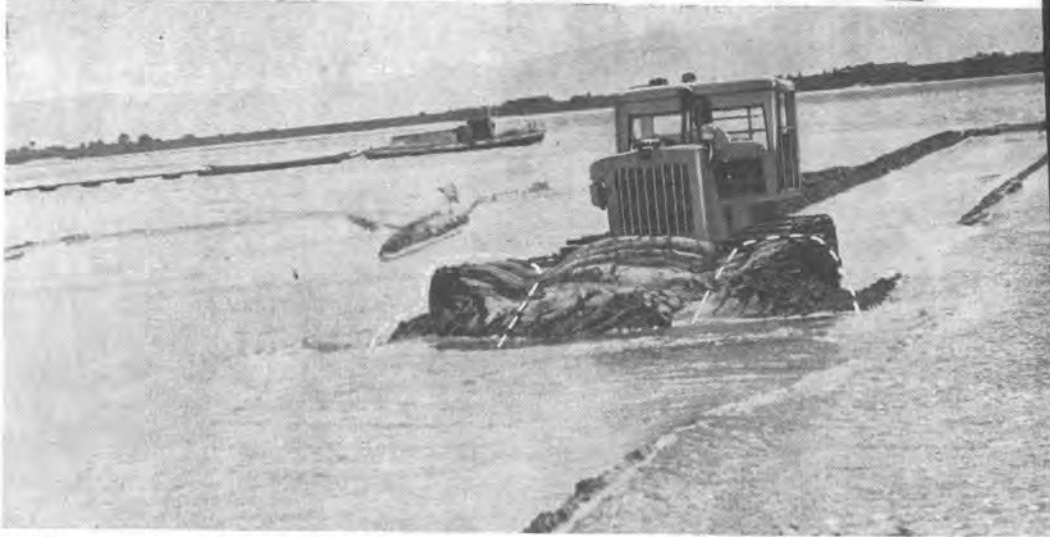
木曾川工事に於けるD80に装着した本機の水中作業（点線部分の土砂が従来より余分に運搬出来る）
