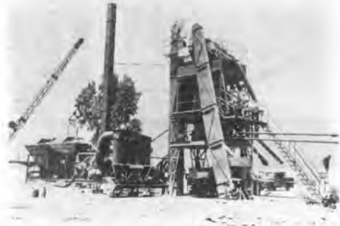
写真-1 50 t/h B.G. アスファルトプラント
