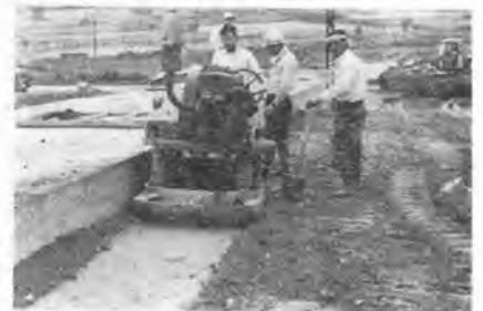
写真-3 ソイルコンパクタによる構造物裏込の締固め状況
