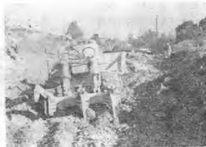
写真-6 リッパ付ブルドーザによる大日川掘削状況
