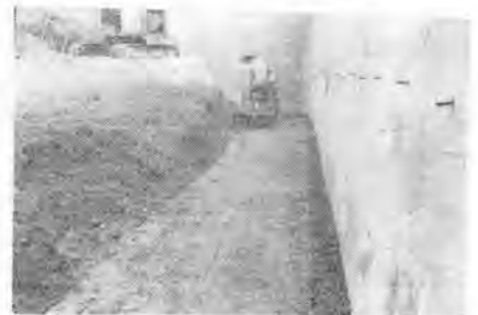
写真-2 バイブレーションローラによる構造物裏込の締固め状況
