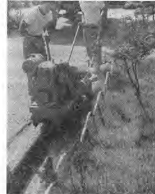
写真-3 カーバー施工状況
