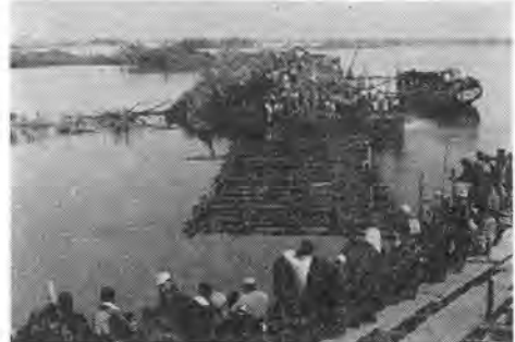
写真-2 木沈位置定め
