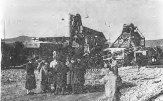
写真—73 オーストリア——オートバンに使用中のアスファルトプラント（ドイツアルフェルダー社製）
