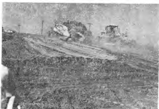
写真—4 サンフランシスコ北郊外デービスハイウェイ工事。 モータースクレーパーが高速で白じんをもうもと上げてつばしる。モーターグレーダは運搬路の整形に余念ない。
