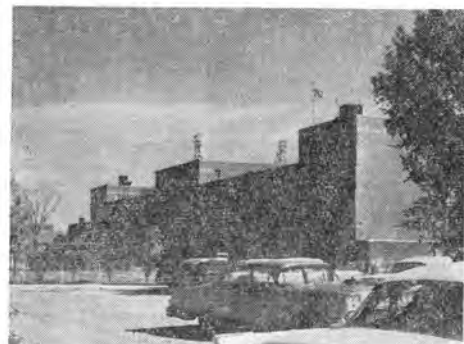
写真-38 アリスチャルマー社の主機工場の外景
