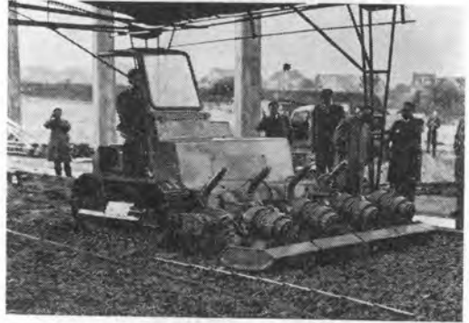
写真—59 アーヘン工科大学…振動締めめ機械の実験
