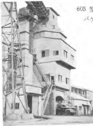
生コン用 バッチャー プラント 56 S ミキサー 2 基
