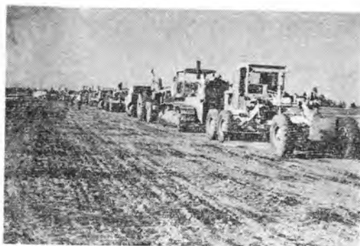
写真—5 デービスハイウェイ工事。 グレーダ, ブッシー, モータースクレーパーの一群。
