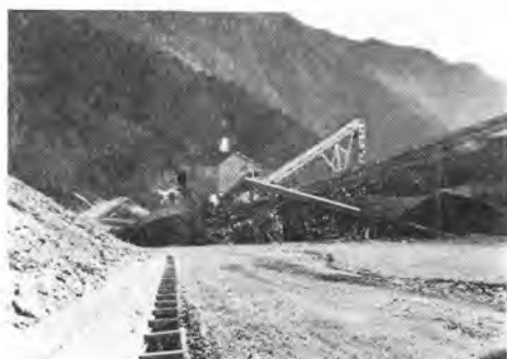
写真-4 扇沢骨材集積場
