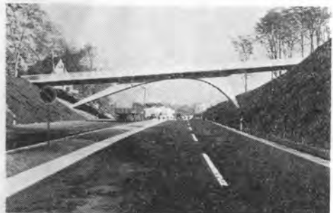
写真—62 ドイツ—ブッペルタール付近のオート バーンに架る新しいオーバブリッジ
