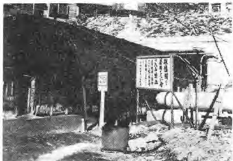
写真-2 大町ルートのトンネル(5.5 km)大町側入口 ここから骨材はベルトコンベヤ、自動車は時間割りの一方 交通となる。
