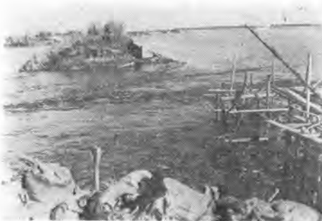
写真-1 名古屋市港区南陽町天目地内日光川通り 左岸夕止工事（原形）
