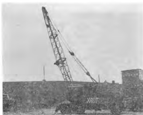
写真—42 ニューヨーク市の既設地下道の取壊し作業
