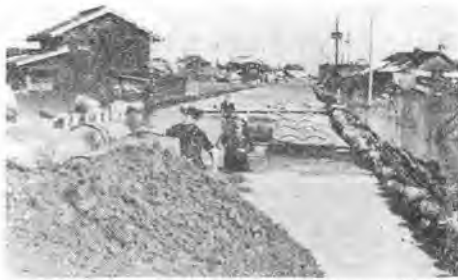
写真-4 1号国道ドラム缶工法による施工
