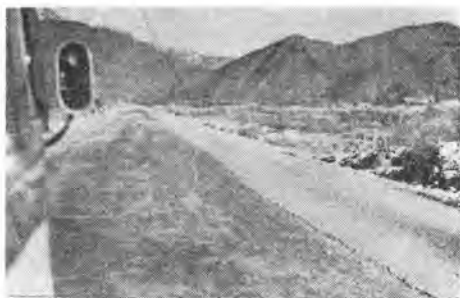
写真-1 大町ルートへの運搬道路
