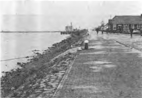
写真—57 オランダ—干拓堤防石張りとレンガ道
