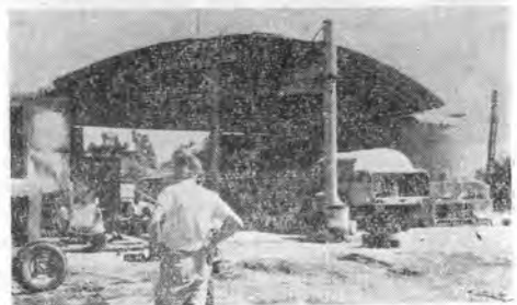
写真—16 サンディエゴ——フリーウェイ現場修理工場
