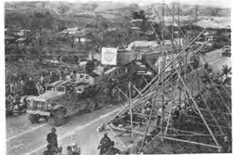
写真-5 300 t トレーラによる載荷試験 ダイヤルゲージによるタワミ測定用の 足場が写真の右手に見える
