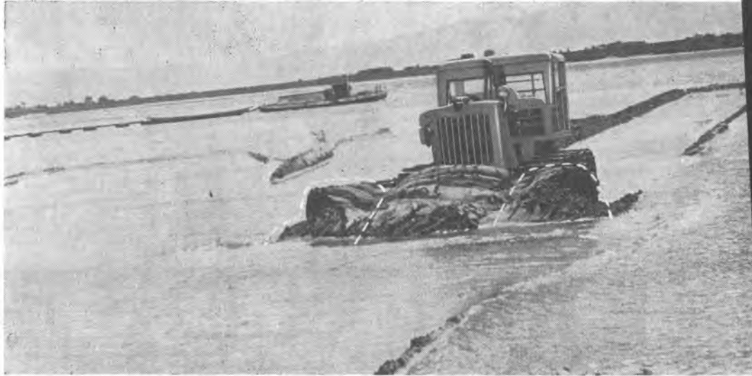
建設省木曾川工事に於ける D80 に装着した本機の水中作業（点線部分の土砂が従来より余分に運搬出来る）
