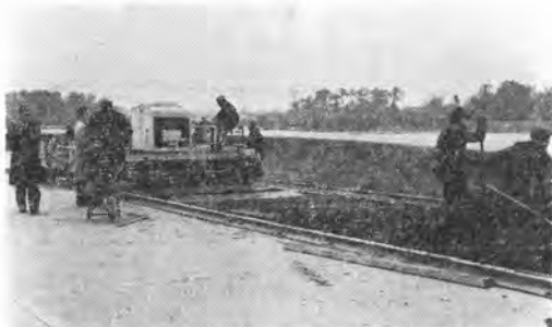
写真—64 ドイツ—バーデンバーデン付近のオートバーン 新設現場にて、ABG フィニッシュ
