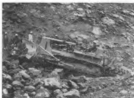
写真-2 ダム工事におけるD120 油圧リッパ付ブルドーザ
