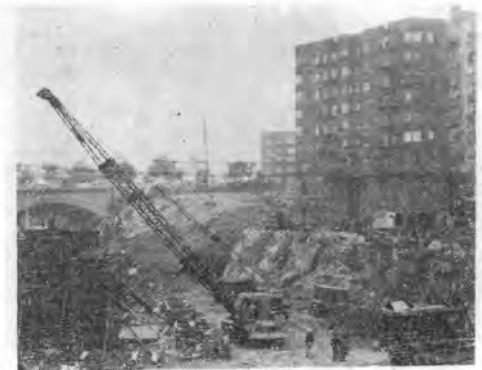
写真—43 ニューヨーク市のエクスプレスウェイ現場でクレーンで鉄製型わくを組立中
