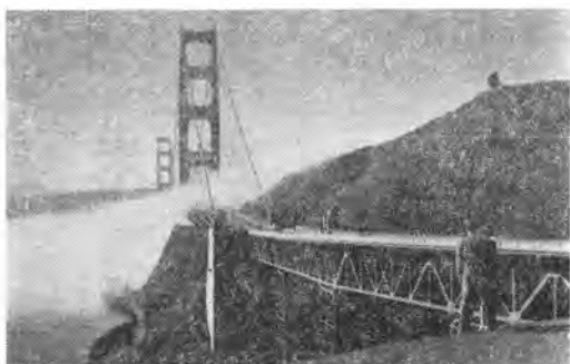
写真—6 サンフランシスコ——ゴールデングリッジ。 霧につつまれた橋の下を汽笛を鳴りかわして船が行く。
