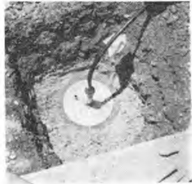
写真-4 カールソン土圧計埋設状況
