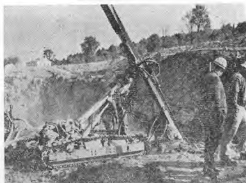
写真—46 ベルモント州—ノーススプリングダム(アー スダム)の余水吐掘削中の自走式ワゴンドリル
