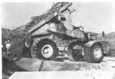
写真-3 骨材プラントの原石材投入口(グリズリーを使わない)
