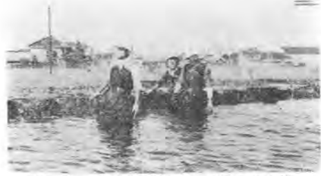
写真-5 1号国道ドラム缶工法による施工
