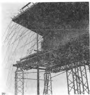
写真—63 ドイツ—ブツベルタル付近 工事中のオートバーンの P.S 橋
