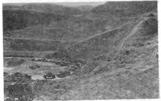
写真—14 サンタモニカフリーウェイのマルホーランドヒル現場。 D9を主力とし3段ベンチによる掘削、ベルトローダおよび26 cu yd ボトムタンク、ダンデムトレーラ運搬による大土工事(土量1,100万 cu yd)
