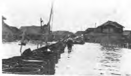
写真—8 1号国道ドラム缶工法による施工
