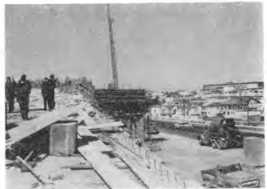
写真-2 サンフランシスコ市内——ベイシヨア、アルメニー、インターチェンジ高架橋工事。レミコンを使用し、クレーンドラックを用いてコンクリート打設。
