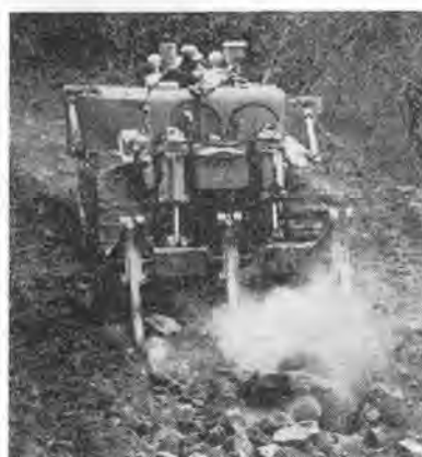
写真-3 道路建設工事におけるD120 油圧リッパ付ブルドーザ
