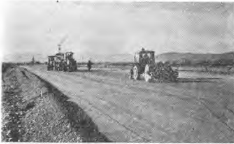
写真—72 オーストリア——オートバンの路盤工。けん引式振動ローラが活躍している
