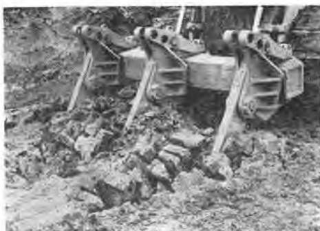
写真-4 川床の硬岩の破碎状況
