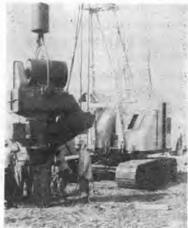
写真-3 ダイハツ VPD-50 型バイブレーションパイルドライバ
