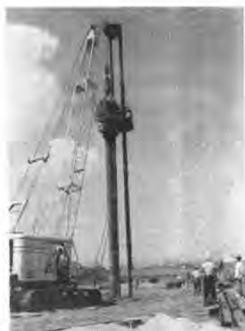
写真-5 鋼管パイル打込の状況
