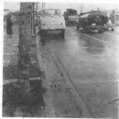
写真-3 モータースイーパーで清掃した後の路面の状態
