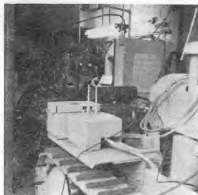
写真—2 Engine Dynamometer Test 運転手席前の Bonnet に取付いているのは油圧測定用パイプの支持金具、吸気管のところに巻きつけてあるのは回転計のケーブル。
