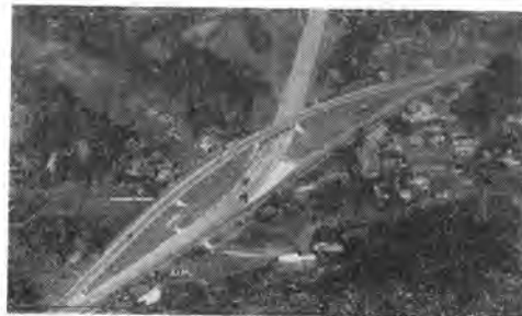
写真-6 34年度に完成した横浜新道
