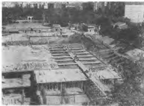
写真一七 完成を急ぐ日比谷駐車場
