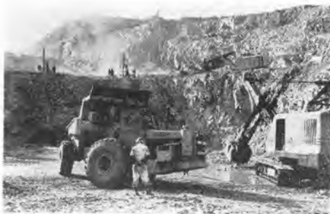
写真-2 牧尾ダム余水吐掘削中、近景
