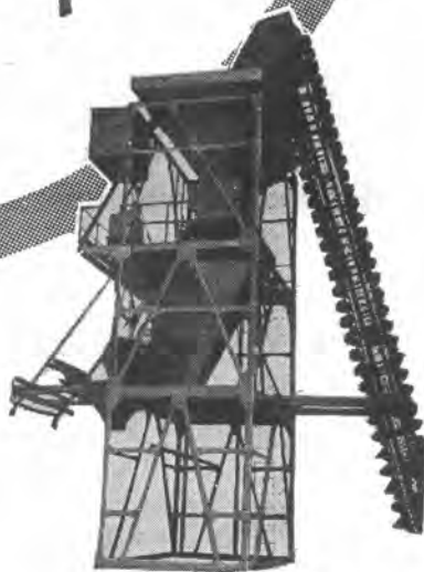
バッチャープラント
