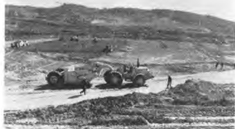
写真-6 東郷調整池ダム、堤敷中央部盛土中
