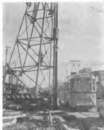
写真-1 都電と接近してくい打工
