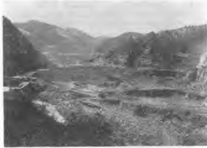
写真—1 牧尾ダム現場（下流側より望む）
