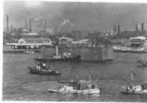
写真-4 若戸橋現場におけるケーソンくい航
