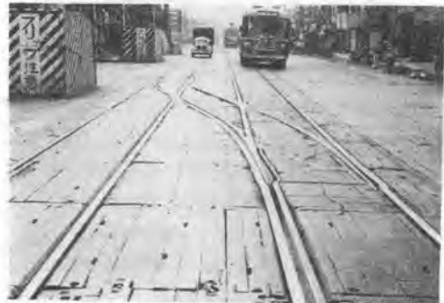
写真-4 路面板張—都電ポイント付近
