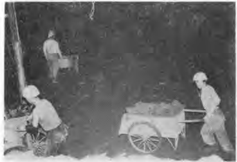
写真-3 掘削土は手押車により運搬
