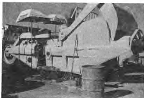
写真-4 大型スクレーパーの改造
