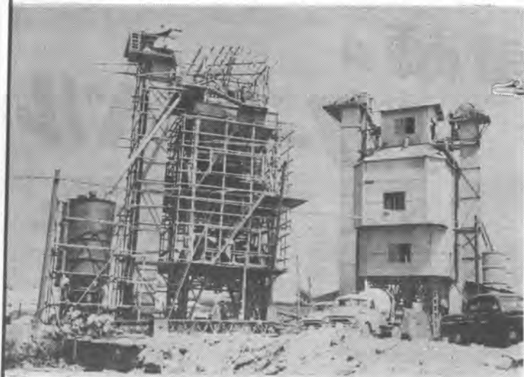
28切の3型 全自動式バッチャー2基
