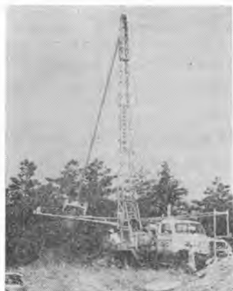
写真-1 作業時の装輪式カルウェルド機
