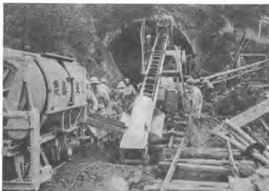
新丹那隧道工事現場
