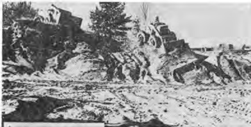
写真-2 85 A 作業状況
