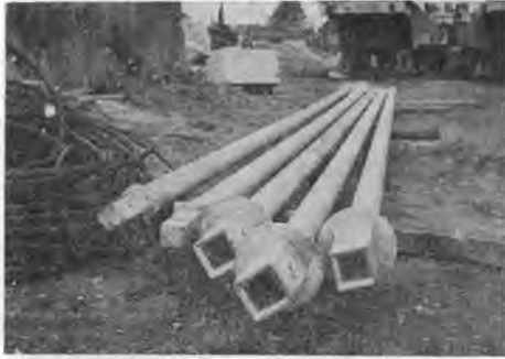
写真-6 継ぎ足し用のステムロッド
