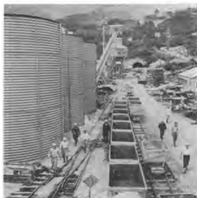
写真—1 新丹那トンネルの来官口 (現在両口から合わせて導坑が 50% 進んでいる)
