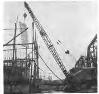
写真-2 酒匂川橋りょう (ケーソンは全部完了している)
