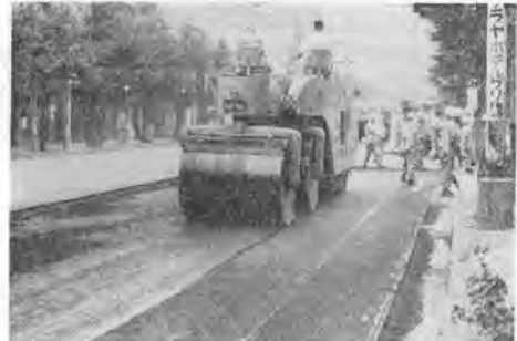
写真-3 基層アスファルトコンクリートの締固め
