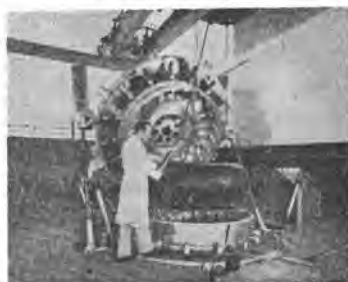
写真-7 鋳型内の大きな鋼製チューブキャストを通じて山かけ面全体にくまなく熱が加えられる。
