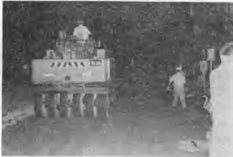
写真-2 上層路盤の締固め
