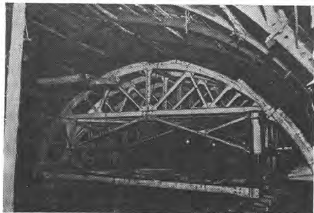
スチールフォーム D=4,800 L=10,800 (株)間組シンセン 伊豆丹那建設所納入
