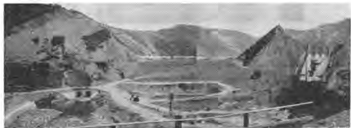
写真-1 ダムの全景中央が本堤(8分通り築堤完了)右側越流せき
