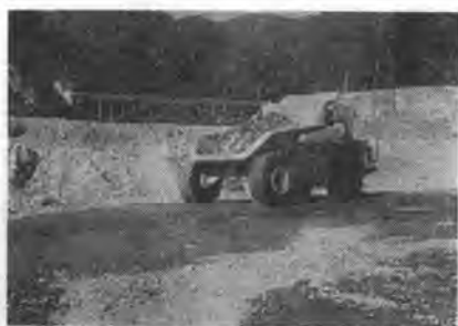
写真—3 堤体材料の運搬
