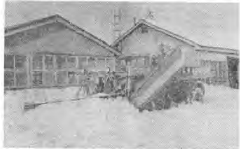
写真-6 試験車除雪状況
