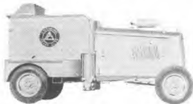
50型マドジャック マドポンプ能力 6.3 m 3 /h
