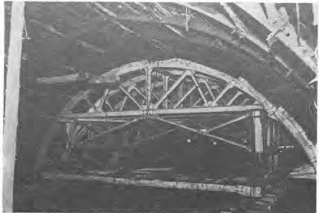
スチールフォーム D=4,800 L=10,800 (株) 間組シンセン 伊豆 丹那建設所納入
