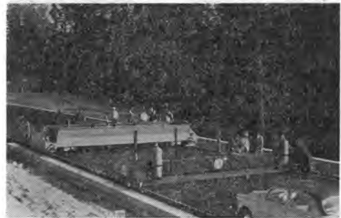
写真-7 写真手前は "Gußasphalt Spreader" と、後方 "Chips Spreader"
