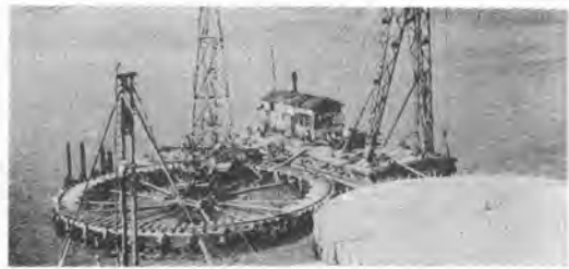
写真-4 セル岸壁工事、塩釜港
