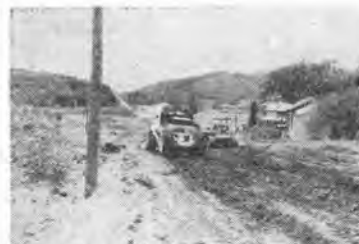
写真-7 土を満載して土捨場へ向い運搬路を行くモータスクレーバの後姿(左側)
