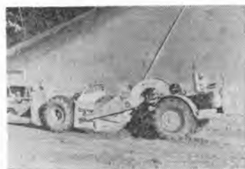
写真-5 プッシャに後押しされながら掘削積込中のモータスクレーバ
