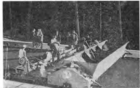
写真-8 写真右方は "Chips Spreader" が既に Chips まきを終わり、左方は "仕上げ ローラをけん引して仕上げているところ。
