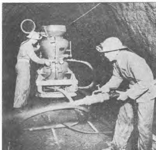
コンクリートをトンネルの中で吹付作業中
