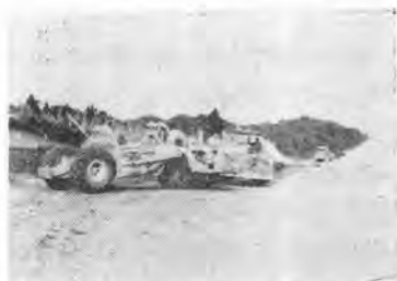
写真-3 土取り場へきたモータスクレーバが方向変換している状況
