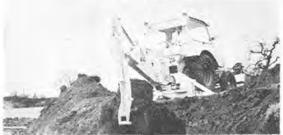
バックホー作業
