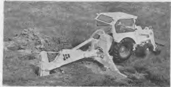
スケヤホール（四角孔）作業
