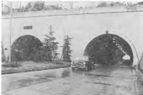
写真-1 横浜バイパス出入口
