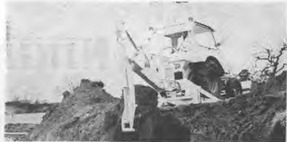
バックホー作業
