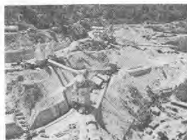
写真-4 奥只見ダム工事用仮設備状況
