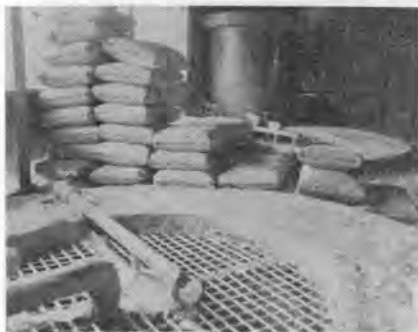
写真-2 溶解槽の投入部
