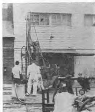
写真-2 せん孔試験状況
