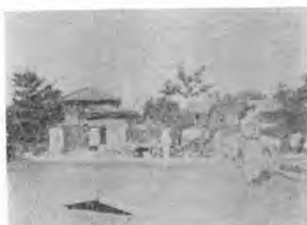
写真-2 ブローアップして持ち上ったコンクリート版
