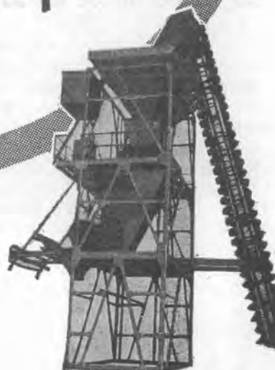
バッチャープラント
