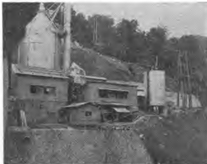
写真-1 フライアッシュ溶解所 および貯蔵タンク
