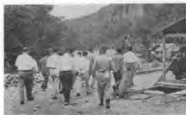
写真-1 砂防ダム工事現場
