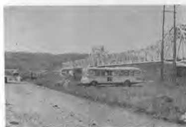
写真-4 帯広川合築堤工事現場
