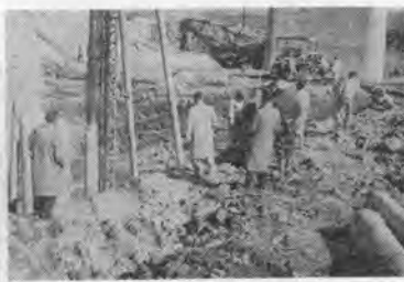
写真-5 帯広川合築堤工事現場
