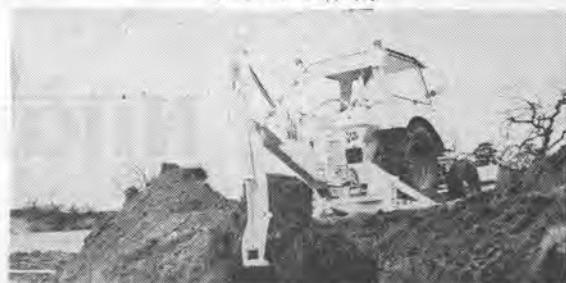
バックホー作業
