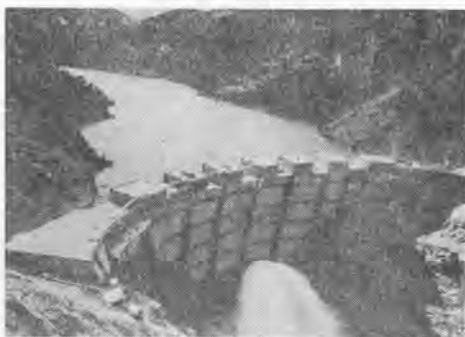
写真-1 黒部第4アーチダム建設状況
