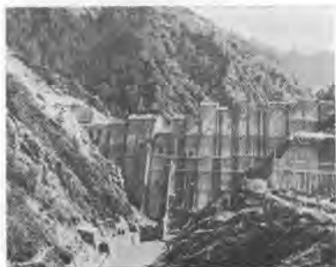
写真-3 奥只見ダム建設状況
