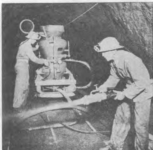
コンクリートをトンネルの中で吹付作業中
