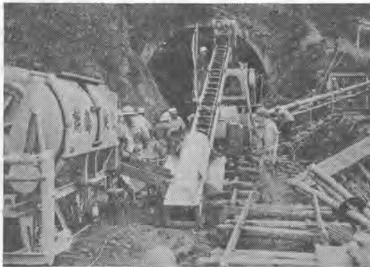
新丹那隧道工事現場
