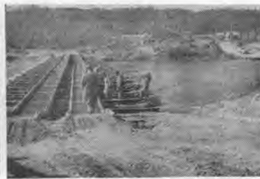
写真-6 帯広帯広川合築堤工事現場 (自衛隊浮橋)
