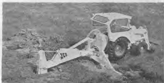
スケヤホール（四角孔）作業
