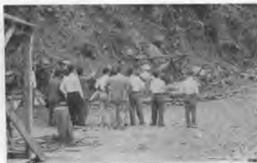
写真-2 砂防ダム工事現場
