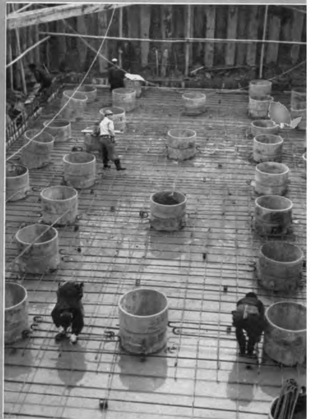
庄内新川橋基礎鋼管くい打上り ↓ (φ = 750mm)
