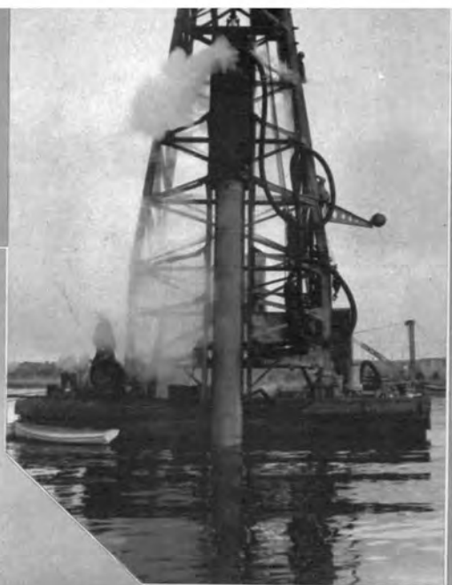
↑ 庄内川橋鋼管くい打工事 (マキナンテリーS14くい打船による)
