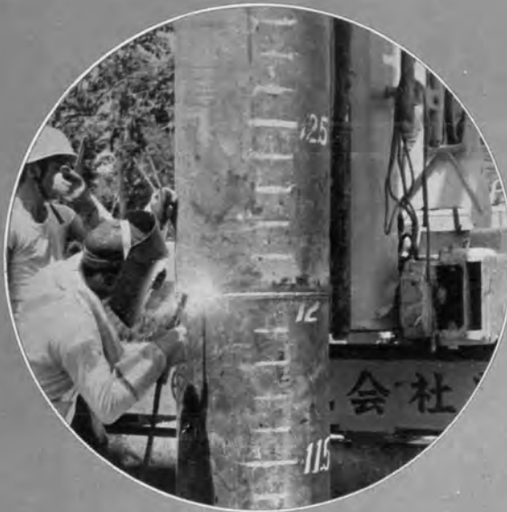
町屋川橋鋼管くいの溶接
