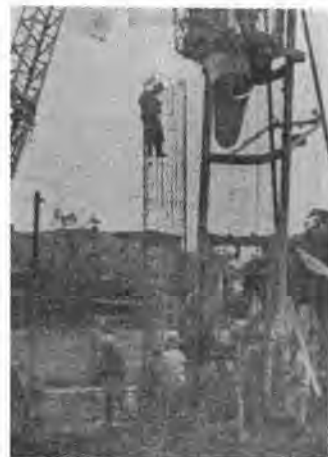
写真-1 ベノト掘削機で作業中
