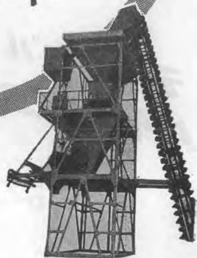
バッチャープラント
