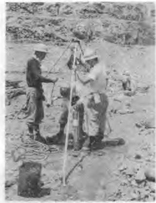
写真-3 装薬状況
