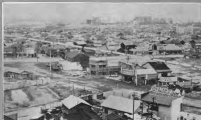
築地口より中川運河方面を望む ここは高架構造となる
