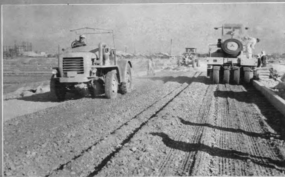
名古屋市港区寛政町試験舗装区 ソイルセメント施工の状況 (三菱アルパレタイヤローラと酒井自走式スタビライザ)
