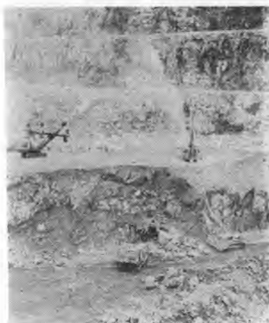
写真-2 積込み状況削孔 右岸側第2ベンチ(表面 EL. 810m) 第3ベンチ (表面 EL. 696m)
