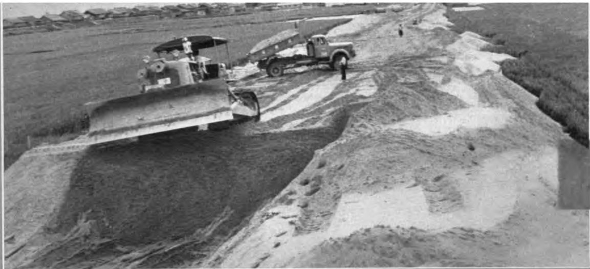
飛鳥道路新設工事——土砂まき出し
