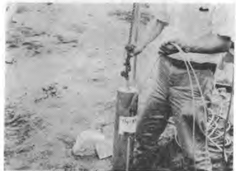
写真-4 装薬状況
