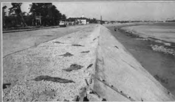
四日市市内海岸堤防と合併施工区完成状況
