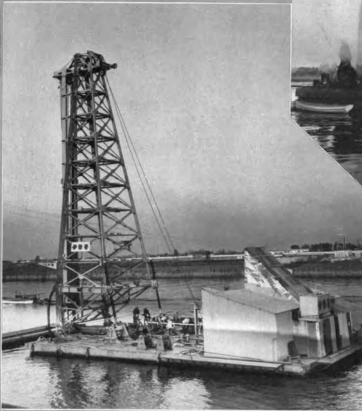
庄内新川橋新設工事 ↓ (マキナンテリーS14くい打機を装備したくい打船)
