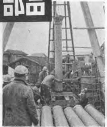
ベント 水中コンクリート投入用ドレミー
