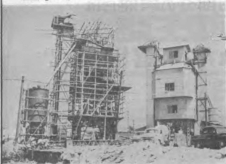
28切の3型 全自動式バッチャー2基
