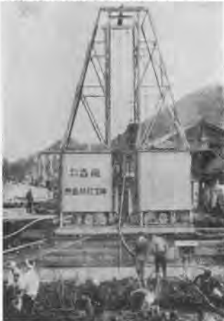
写真-2 森式(旧型)ジェットリフタ全景
