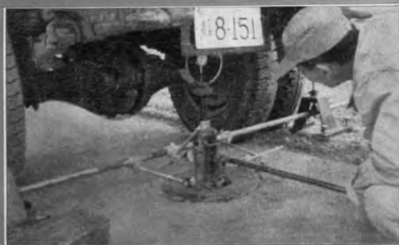
盛土支持力試験状況
