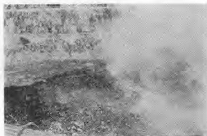
写真-7 ベンチ爆破状況(爆破直後)
