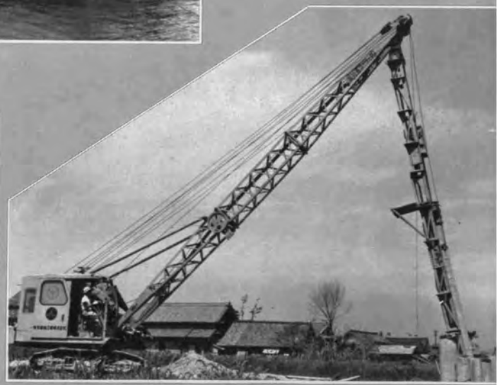
鍋田道路新設工事—溝橋橋台斜くい打
