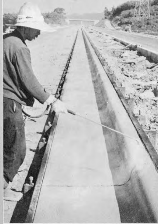
⑩ 完成したカーブアンドガッター養生剤散布中
