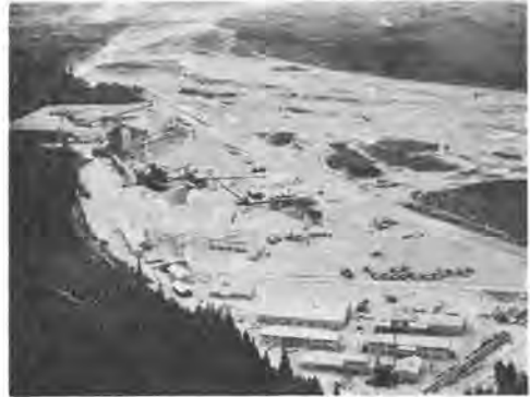
写真-1 骨材プラント全景鳥瞰
