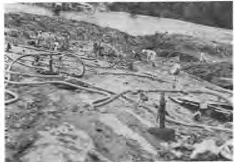
写真-3 低圧グラウト工事セメント注入作業
