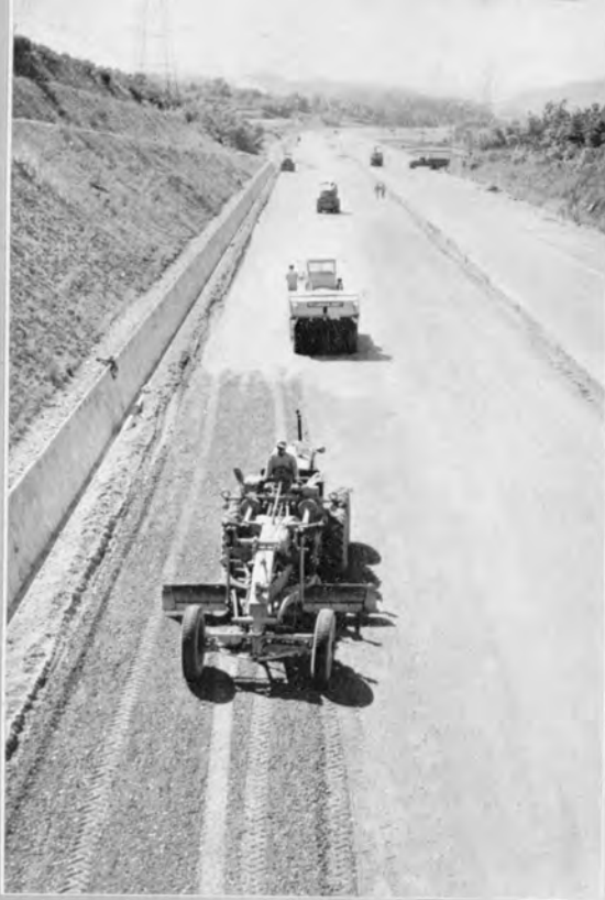
④ ベース材の敷詰め
