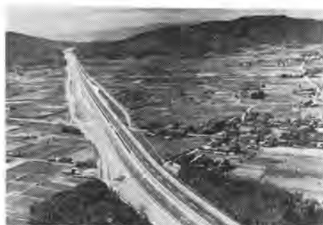
写真—1 山科舗装工事完成——写真中央にバスストップがある
