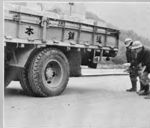
③ 仕上げを行なった路床のブルーフ・ローリング
