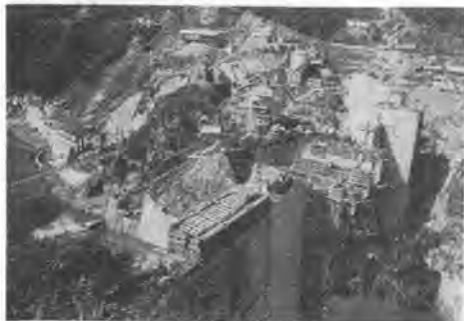
写真-2 大野ダム左岸走行路より本体を望む (36.1.14)
