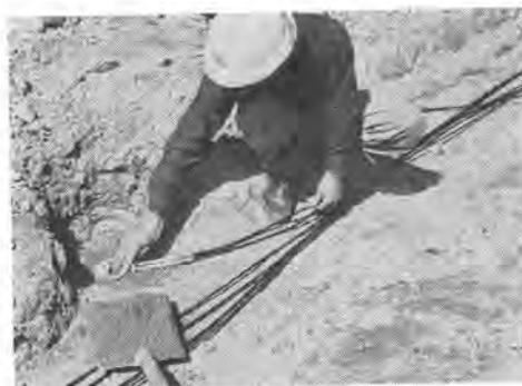
写真-3 ピエゾメータタイプの埋設
