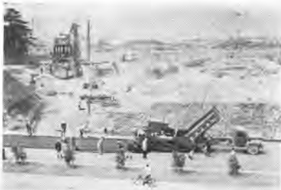
写真-1 舗設作業のアスファルトフィニッシャーおよびアスファルトプラント全景
