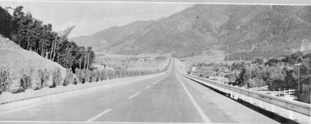
⑲ ガードレールの取付や中央分離帯の植樹を完了して工事は完成
