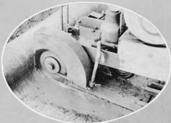
⑨ 収縮目地切断中のコンクリートカッター
