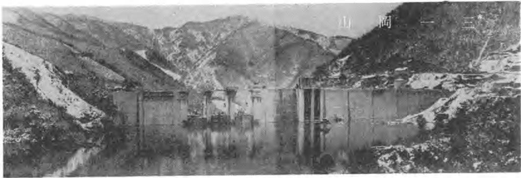
写真-1 大野ダム上流面2次満水時(36.1.14)
