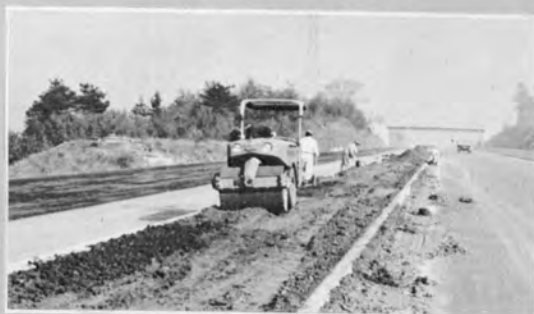
⑰ 中央分離帯客土の転圧 3tインパクトローラ
