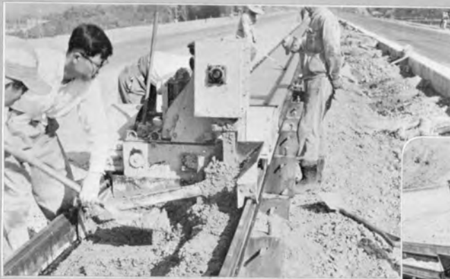
⑦ 打設作業中のカーブアンドガッターペーパー
