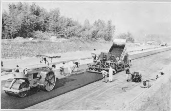
⑮ S A 60アスファルトフィ ニッシャによる舗設作業
