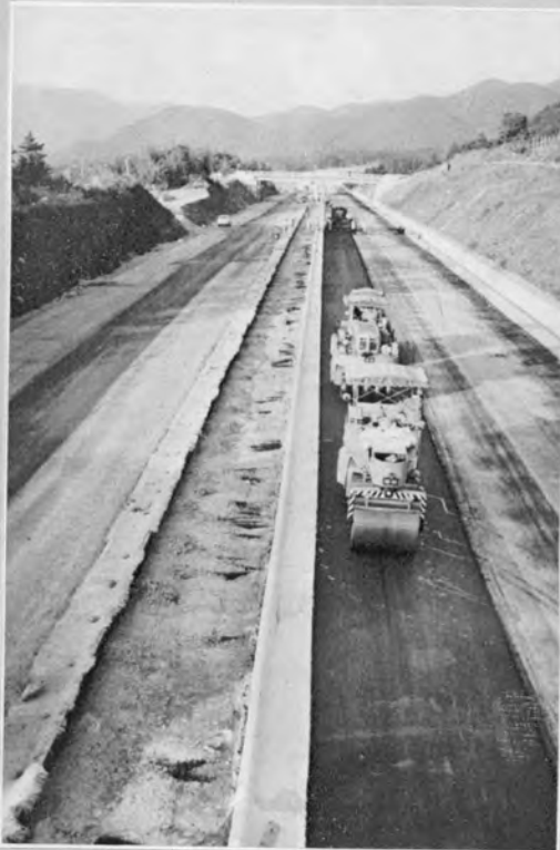
⑯ 舗設作業全景——タイヤローラおよび3軸タン DEMローラによる舗装仕上
