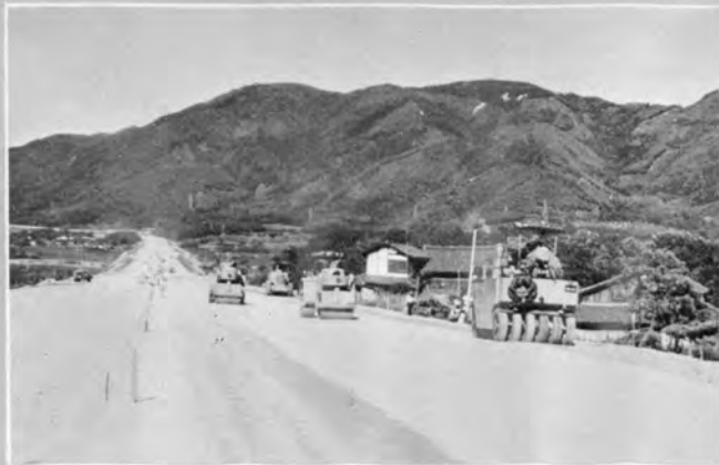
② グレーダでかき起した路床を整形した後の転圧、締め固め
