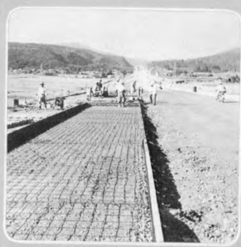
⑤ バスストップ部分のコンクリート舗装施工
