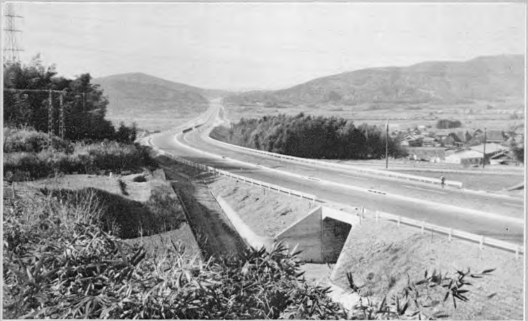
① 名神高速道路山科舗装工事完成全景
