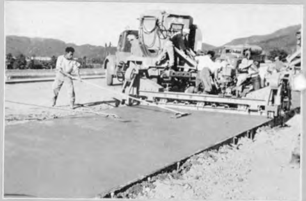
⑥ コンクリート舗装仕上げ ABGフィニッシャ
