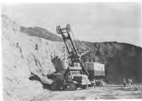
写真-1 150 B ショベルによるストックパイルの掘削
