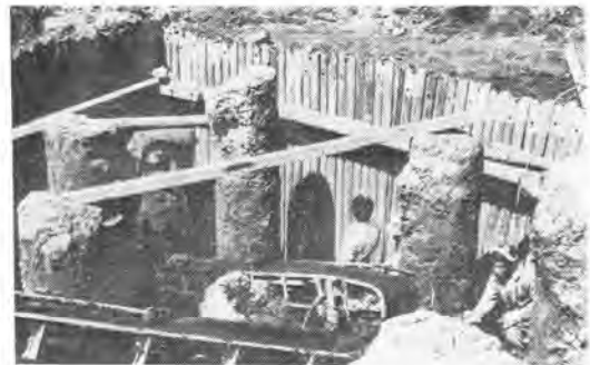
写真-1 カルウエルフ基礎工事
