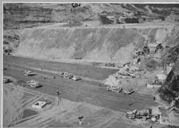
土質材料本体ロック盛立状況—シープスフートルーラによる転圧
