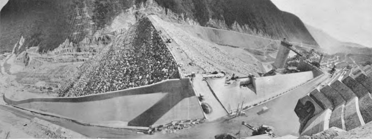
左岸より望むダムおよび右岸
