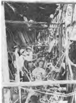
写真-11 カーテングラウト工事削孔作業
