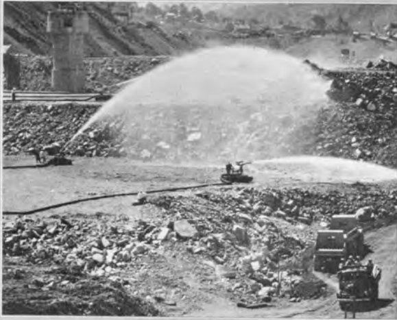
本体ロック盛立—モニターによる射水状況 (昭和33・8・15)
