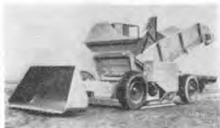
図-2 ロレーン・ローダの掘削姿勢
