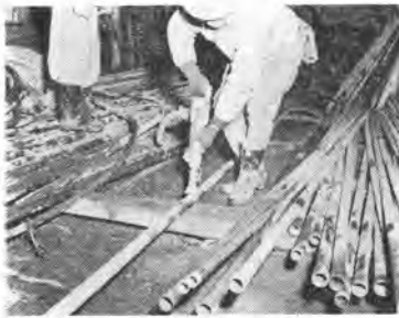
写真-7 注入パイプ掃除
