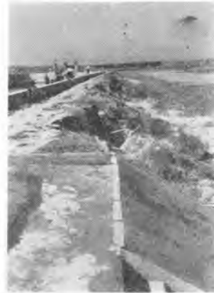
写真-2 図-1 の No. 23 より無被害のアスファルト舗装海岸堤防を望む
