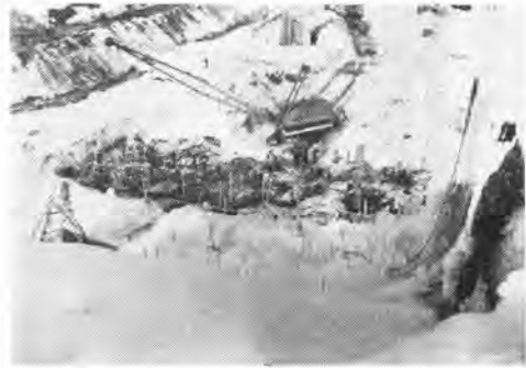
写真-5 冬期間の低圧グラウト作業
