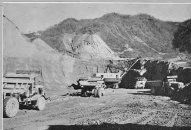
秋町土質材料採取場—ストックパイルで採取作業中の 150Bおよび60TD
