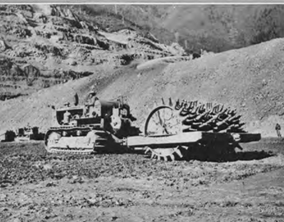
土質材料転圧作業中のシープスフートルーラ
