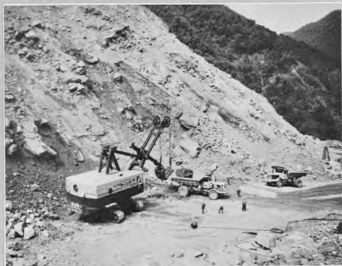
福島谷ロック採取場—稼働中のピサイラス150B およびユークリッド60TD
