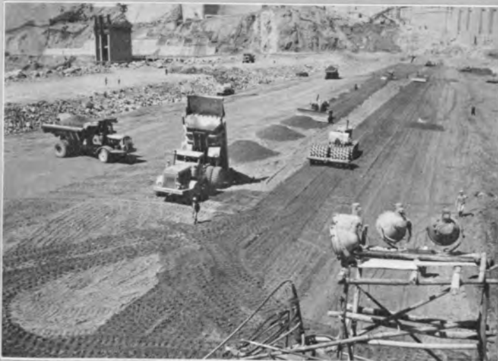
ダム本体土質材料盛立状況 (昭和35・5・16)
