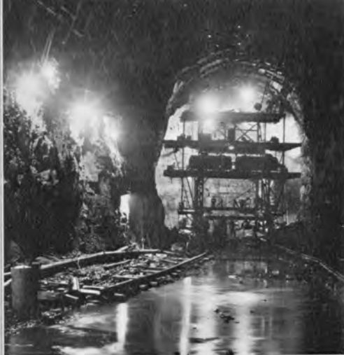
仮排水トンネルNo. 3 坑内ジャンボ
