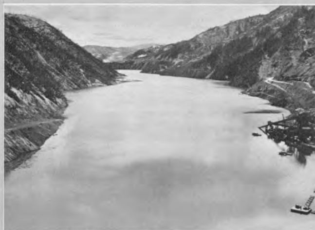
天端より望むダムたん水状況
