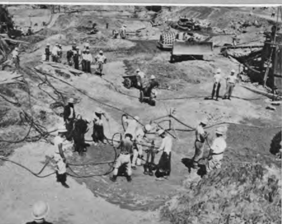
土質材料打設状況
