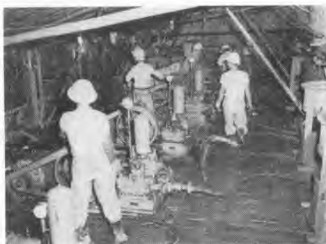
写真-4 グラウトポンプ配置
