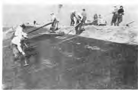
写真一 長浦干拓堤防外ノリ施工中
