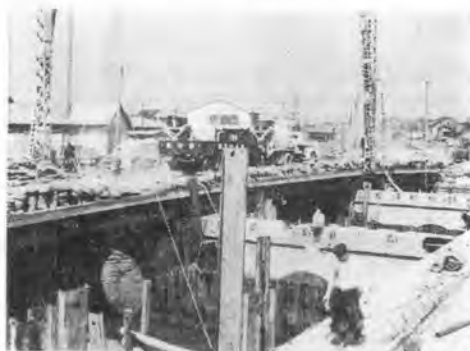
写真—5 関連街路放射 18 号線 浜崎橋架設工事現場
