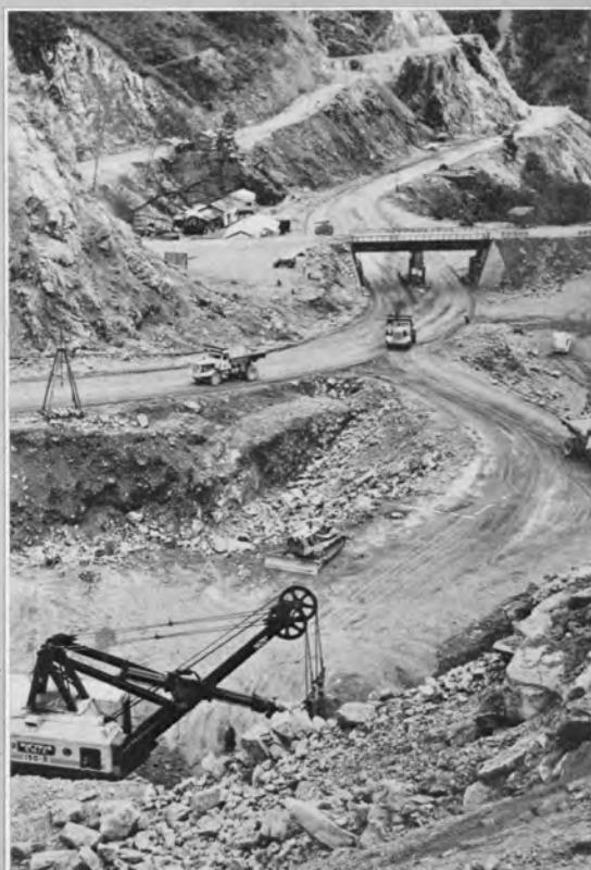
→ ロック運搬道路—原石山付近
