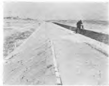
写真-2 図-1 の No. 23 より無被害のアスファルト舗装海岸堤防を望む
