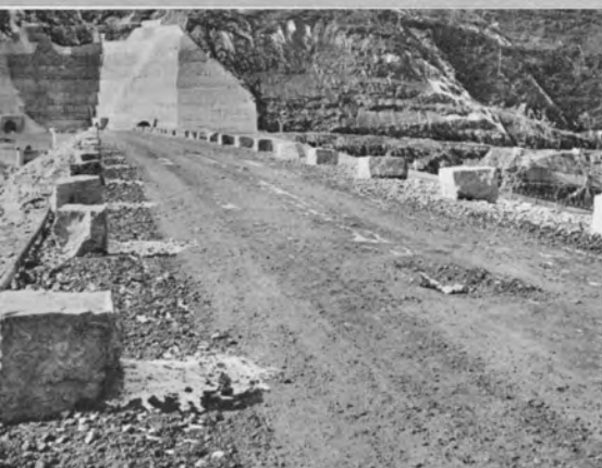
ダム天端仕上げ
