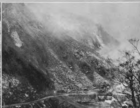
福島谷ロック採取場—125 t 大発破爆発直後
