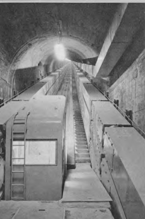
←ケーブルトンネル—密閉母線および インクライン
