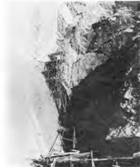
写真-10 カーテングラウト工事機械配置
