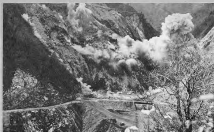
福島谷ロック採取場—125 t 大発破爆発瞬間
