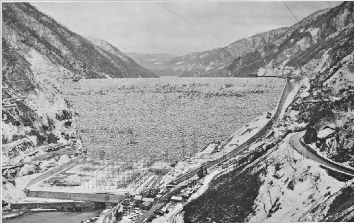
ダム全景—ダム下流より望む (昭和35・12・22)
