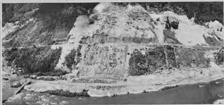
ダムサイトの掘削—右岸より左岸を望む（着工直後）
