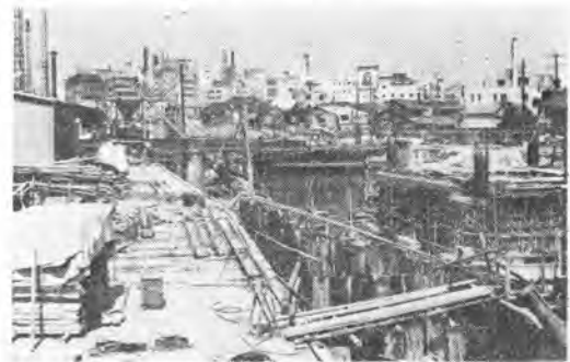
写真-4 汐留駐車場建設工事現場
