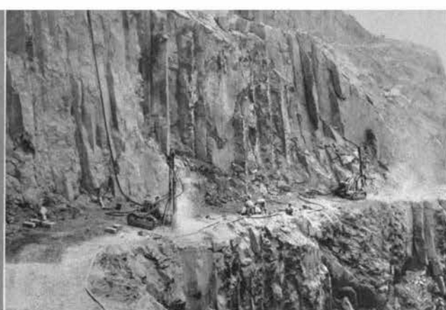
原石山におけるエアトラックドリルによる さく岩作業
