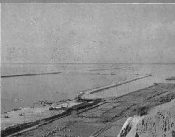
三倉鼻採石場付近の東部承水路堤防工事 東部承水路右岸堤19,360m、左岸堤21,180mの一部である。
