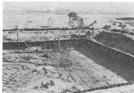
写真-1 南部機場の基礎工事：ウエルポイントを3段設置して基礎くい施工中
