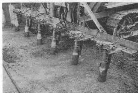
写真-20 パイブレータ引抜き中
