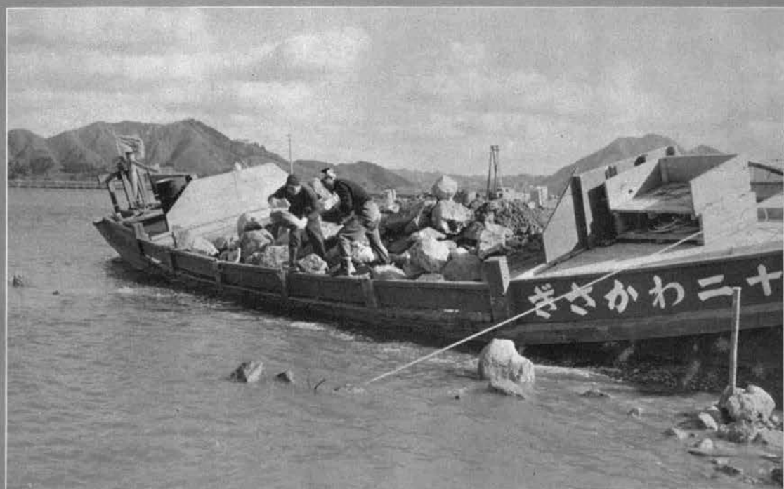
石運船による捨石：このような石運船が約30隻三倉鼻の採石場から石材の運搬に当る。
