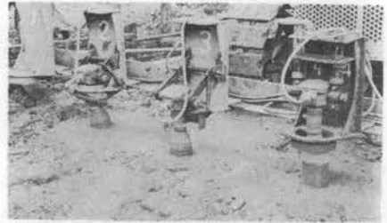
写真-8 コンクリート締固め試験の実施状況
