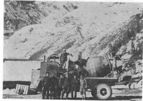
写真-6 トランシットミキサ上に大きい水タンクがある
