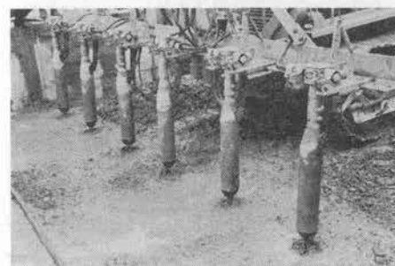
写真-23 パイブレータ引抜き終了、すなわち締め固め1段階終了
