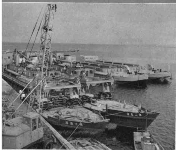
ポンプ船の現地機装
