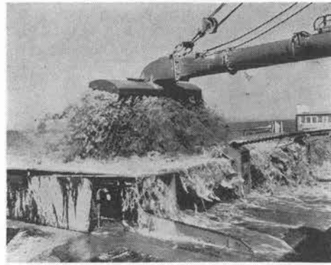
写真-5 稼働中のカッターレス浚渫船(その2)
