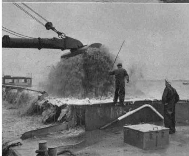
排砂管から土運船へ水と砂の排出
