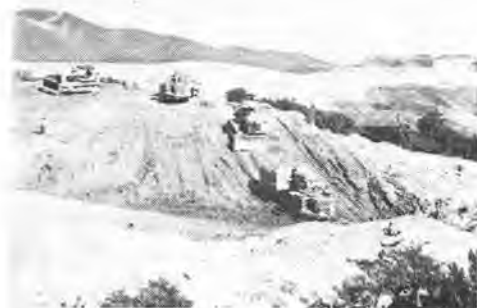
写真-2 舞子団地における DW-21 の施工
