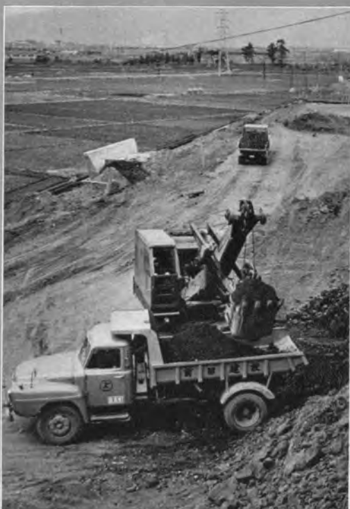
↑ ← 綾瀬—小田原間試運転線区の路盤工 事は急ピッチで進められている。
