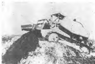
写真二 スクレープドーザ
