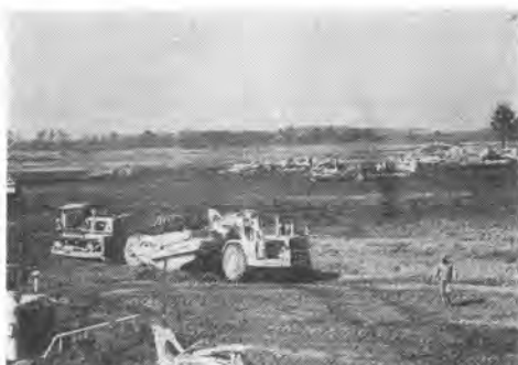
写真-1 村山現場の概況, 切土地区における各種スクレーパ群
