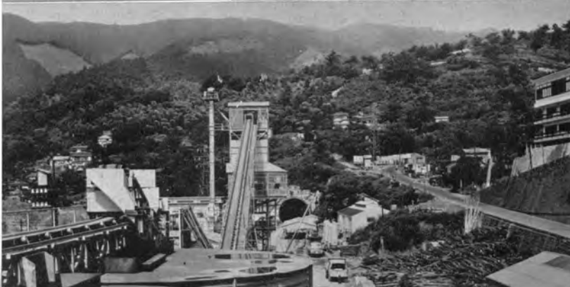
← 丹那トンネル熱海口バッチャプラント付近から坑口を望む
