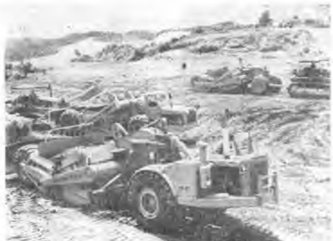
写真-1 奈良ドリームランドにおける DW-21 の施工
