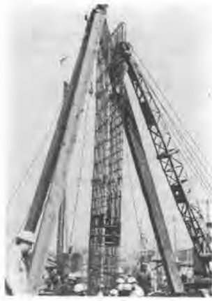
写真-3 鉄筋かごつり込作業
