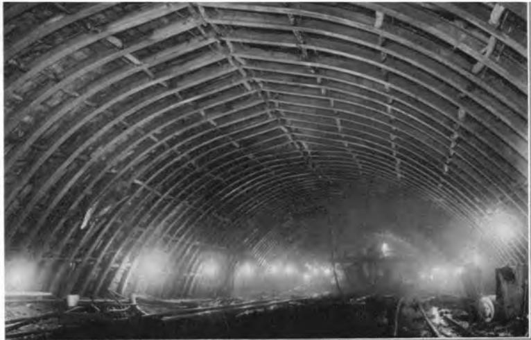
↑ 丹那トンネル熱海口から160m付近 アーチ部H型支保工の組立
