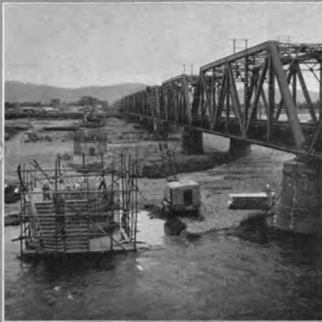
酒匂川橋りょうの橋脚型わく組立
