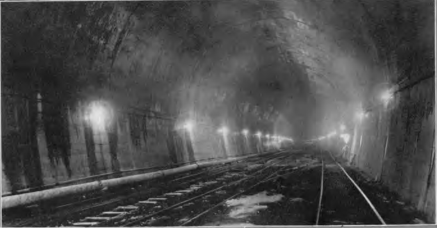
→ 量築完成した泉越トンネル(湯ヶ原)坑口から80m付近
