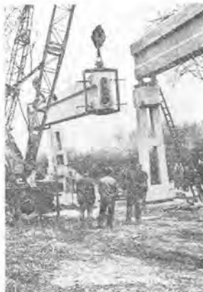
写真-9 モビールクレーンによるけた架設作業
