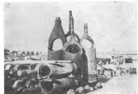
写真-7 サンドポンプ型掘削工具
