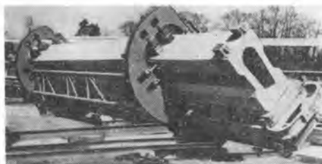
写真-8 けた転倒装置
