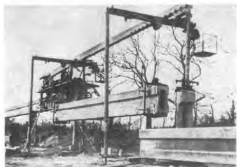
写真-9 けた架設車の一例
