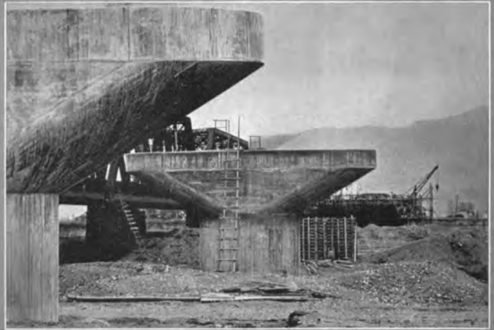
酒匂川橋りょうのできあがった橋脚 裏側に見えるトラスは現在の東海道線。
