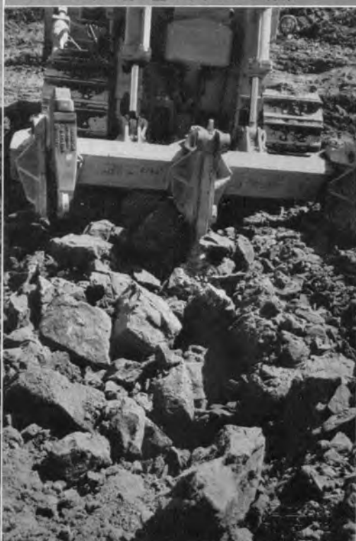
↓ 土取場の硬土盤のリッピング作業
