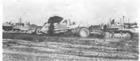
写真-3 クローラ型トラクタ D8(36A) + 国土開発製 16yd 3 スクレーパ、D8(15A) にてブッシュし積込み中
