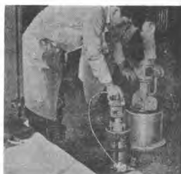
両機の振動作業中
