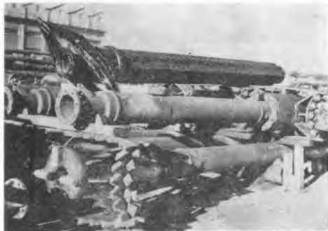
写真-4 掘削工具 その3
