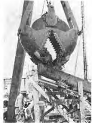
写真-2 特殊型グラブによる掘削作業中
