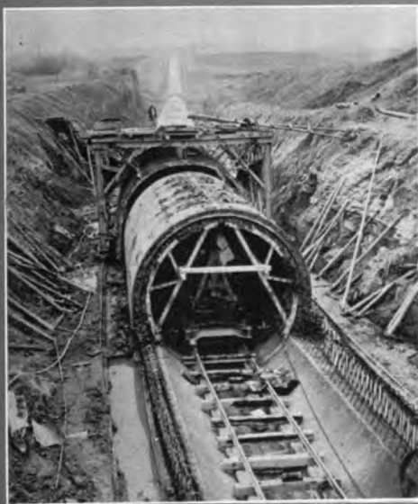
↑ 幹線水路工事：第11工区 上野サイフォン工事
