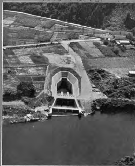
↑完成した兼山取入口（昭和36・3）
