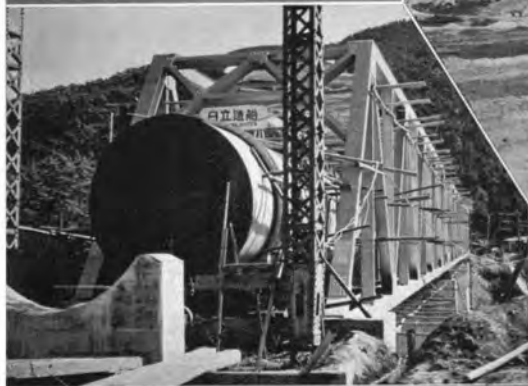
↑ 幹線水路工事：工事中の高蔵寺サ イフォンのサイフォン橋
