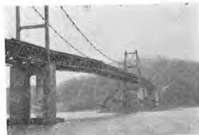
写真-4 小鳴門橋
