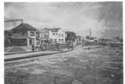
写真-7 鳴尾舗装(直営)コンクリート施工養生左方巻物は養生用シート
