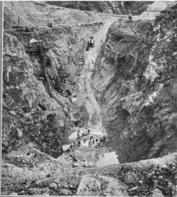
↑床掘中の牧尾ダム (昭和34・5)
