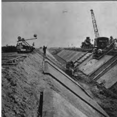
↑ 幹線水路工事：スロープフォーム によるコンクリート打設
