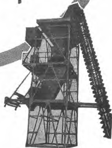
バッチャープラント
