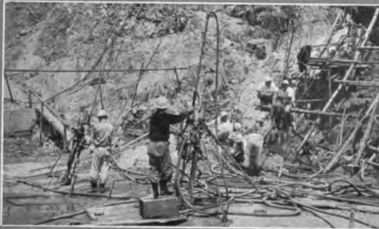
↑牧尾ダム工事：コアトレンチ河床部における グラウトホールドリリング (昭和34・7)
