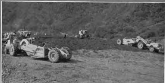
↑牧尾ダム工事：ストックパイルにおける モータスクレーバの活躍 (昭和34・8)
