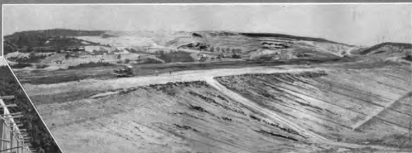
↑ 調整池ダム工事：完成を急ぎながらまき出し、 転圧をする重機群——下流側から望む。向うの 山は土取場
