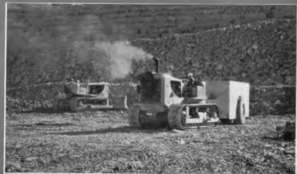
↑牧尾ダム工事：タイヤローラ (50トンポ) によるトランジションの転圧 (昭和34・12)
