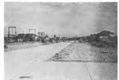
写真-8 鳴尾舗装(直営)一部コンクリートできり
