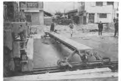
写真-6 鳴尾舗装(直営)コンクリート舗装仕上げ用フロートマシン
