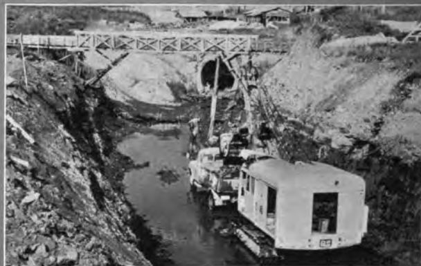
↑幹線水路工事：今渡暗きょ掘削中
