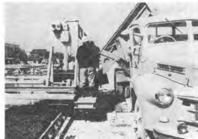
写真-2 鳴尾舗装(直営)コンクリート打設中6.5mコンクリートスプレッダと生コン運搬サイドダンプトラック
