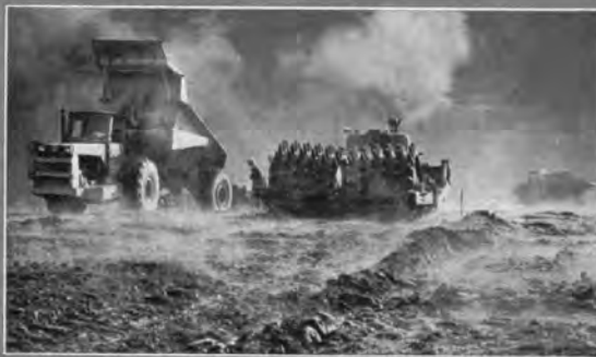
↑牧尾ダム工事：シーブスフトローラによる コア転圧夜間作業 (昭和35・11)
