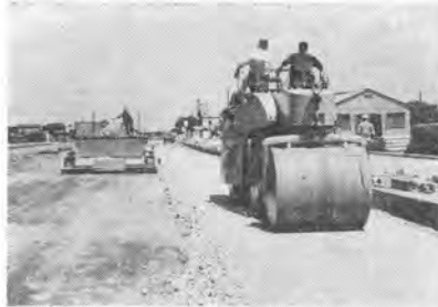
写真-1 鳴尾舗装(直営舗装)三軸ローラとアグリゲートスプレッダ(砕石散布機)
