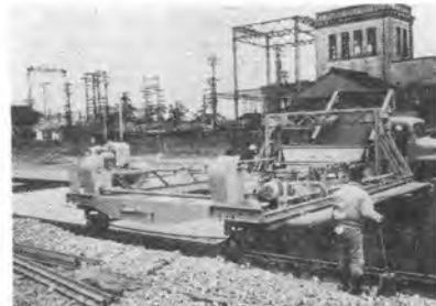
写真-3 鳴尾舗装(直営)コンクリートスプレッダ
