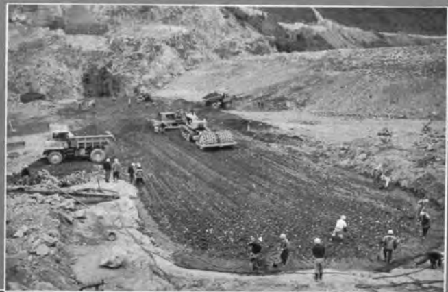
↑牧尾ダム工事：中心コア部のまき出し、転圧中
