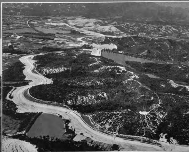
↑ 幹線水路：城東開水路完成
