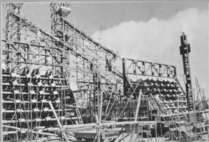
↑橋台アンカーブロックのコンクリート打設
