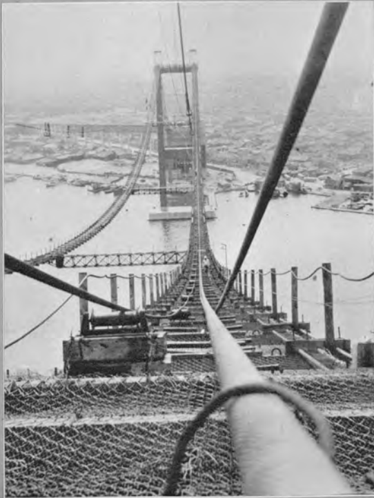
↑メインケーブルの張り渡し作業
