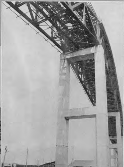
↑ほぼ完成した取付部の一部
