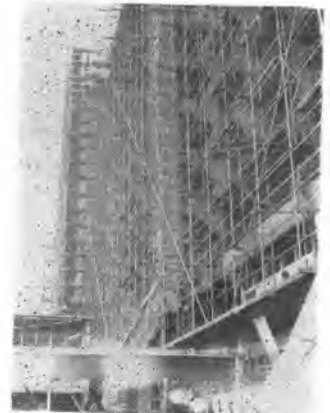
写真-2 メインビル南側足場
