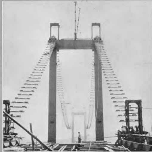
↑主塔間に架設されたフット・ブリッジ
