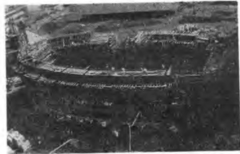
写真-5 バンケットホール立上り仮わく施工中(最終) 屋根鉄骨
