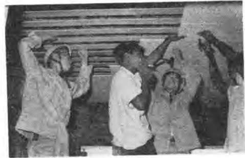
写真-6 室内天井テックス貼付指導中 (パーライトボード)
