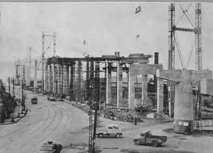
↑取付部鉄骨鉄筋コンクリートラメンの施工
