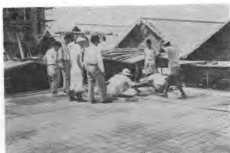
写真-7 レストラン屋根モルタル防水指導中
