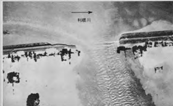
↑昭和22年9月キャスリン台風による堤防決壊状況 (埼玉県北埼玉郡大利根村地先新川)
