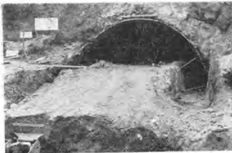
写真-12 リッピング直前のC型掘削
