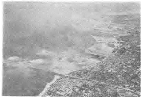
写真一 埋立工事中の堺臨海工業用地の全景 (1961 年 5 月)
