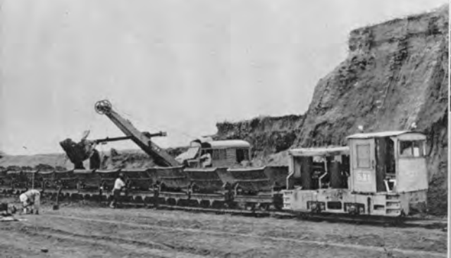
← パワーショベルと7tディーゼル機関車による旧堤撤去工事 (利根川古河地先)
