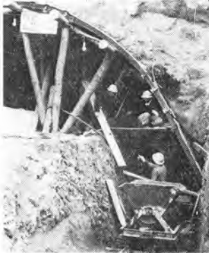
写真-11 C型掘削の一部
