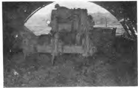
写真-13 リッピング(三菱油圧リッパ)
