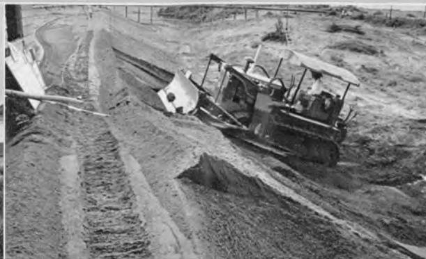
↑浚渫土砂利用築堤工事
