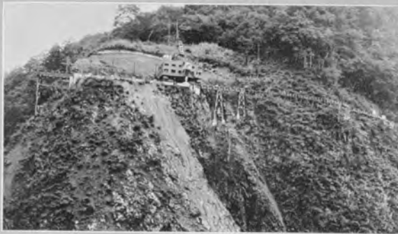
↑菌原ダム左岸—10tケーブルクレーン・エンジンタワー
