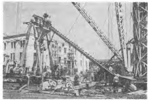
写真-3 霞ヶ関電々公社の建築現場のムカデコンベヤ
