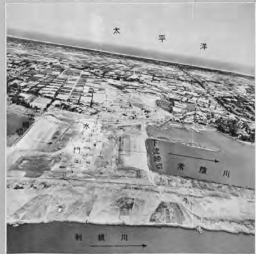
↑ 上空から見た常陸川逆水門工事現場 水門 8基 閘門 2基
