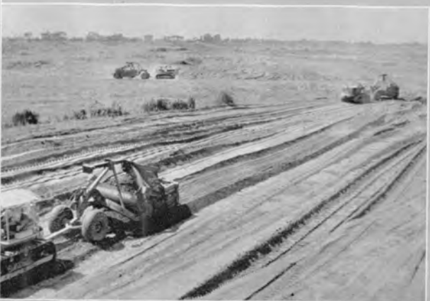
↑スクレーパによる掘削築堤作業
