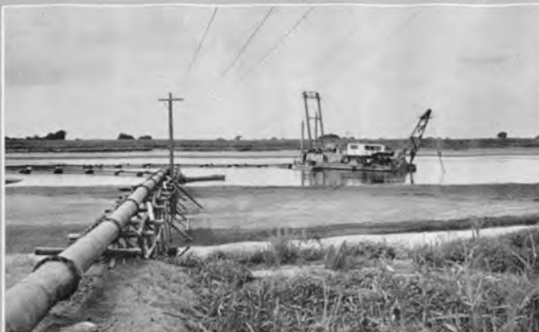
↑500HPポンプ船による浚渫作業 (利根川上流川俣地先)
