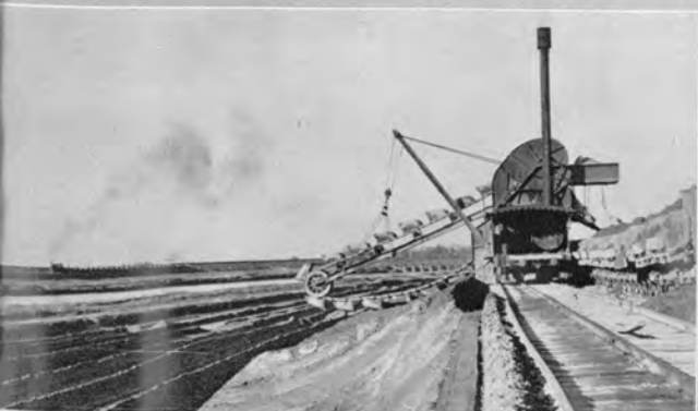
← 昭和23年当時における120m 3 /hスチームラダーおよび20tスチーム機関車による掘削築堤工事 (江戸川開宿地先)
