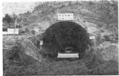
写真-14 C型掘削完了
