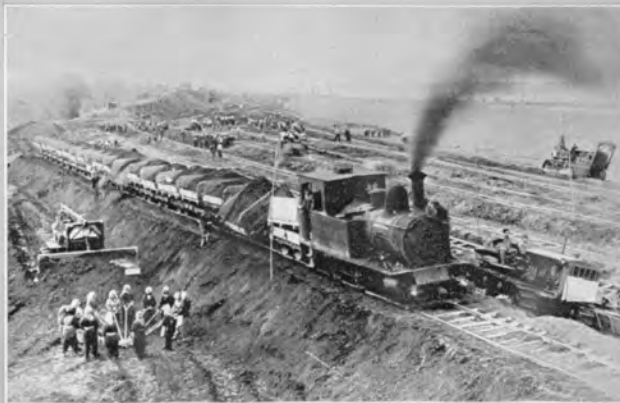
↑同右災害復旧工事—当時払下げの D8ブルドーザが大活躍した
