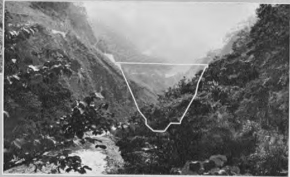
↑菌原ダムサイト—下流側から望む
