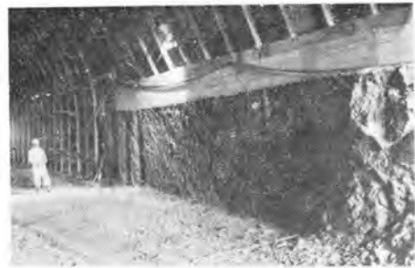
写真-15 完了したC型掘削(後方は全断面掘削を行なったもの)
