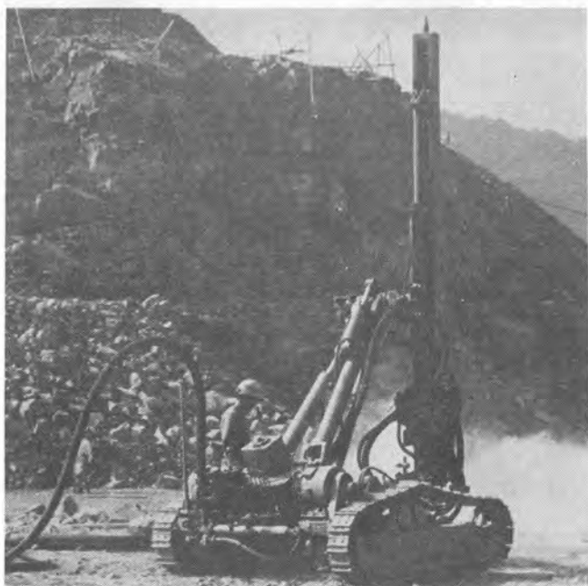
牧尾ダム工事現場
