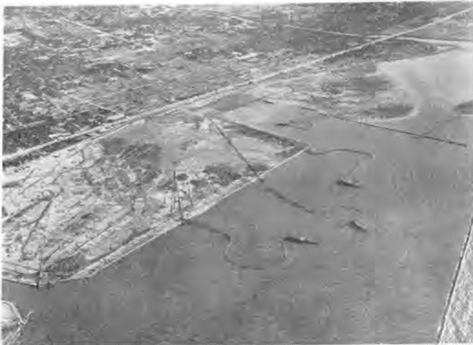
写真-5 造成工事中の第5区埋立地の一部(1961年1月)
