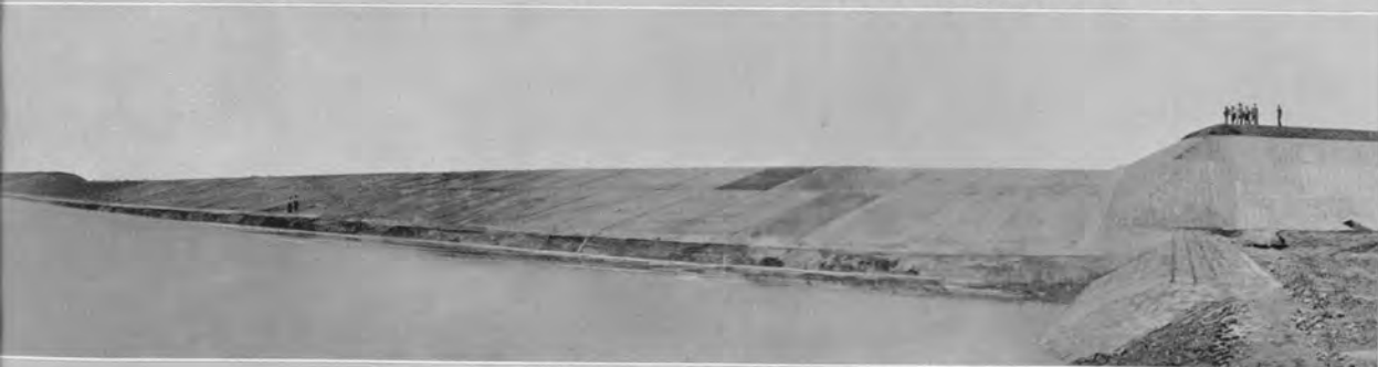
↑復旧した菅生越流堤—川裏上流部から下流部を望む (昭和35・10 完成)
