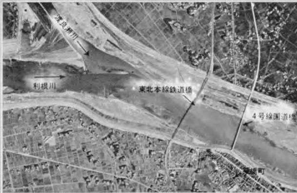
←埼玉県栗橋上空から見た改修後の利根川
