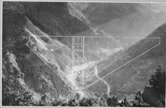
↑下久保ダムサイト—下流側から望む
