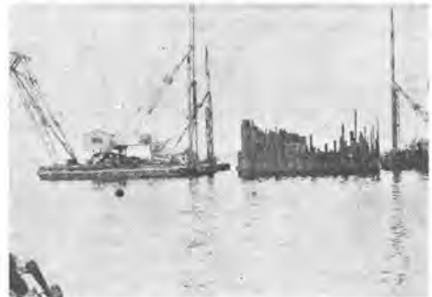
写真-5 工事状況
