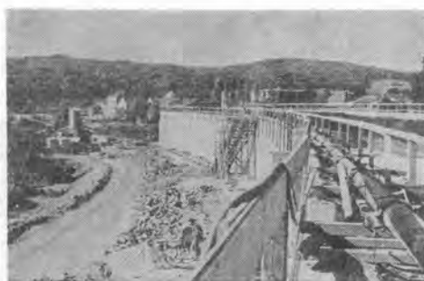
写真-8 アウトバーンの橋りょう導工事に使用中のコンクリートポンプ 輸送距離最大 400 m, 高さ最高 18 m
