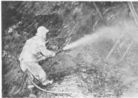
写真-3 き裂の多い岩石の補強吹付け
