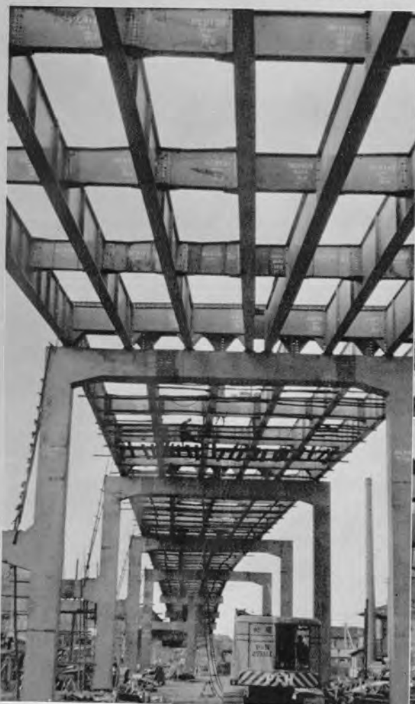
↑ 鉄骨構造部を示す（1号線）
