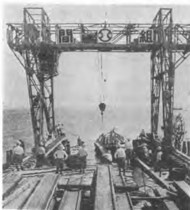
写真-2 12.5t ゴライアスクレーン
