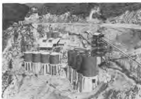
写真-1 ふるい分工場および製砂工場全景
