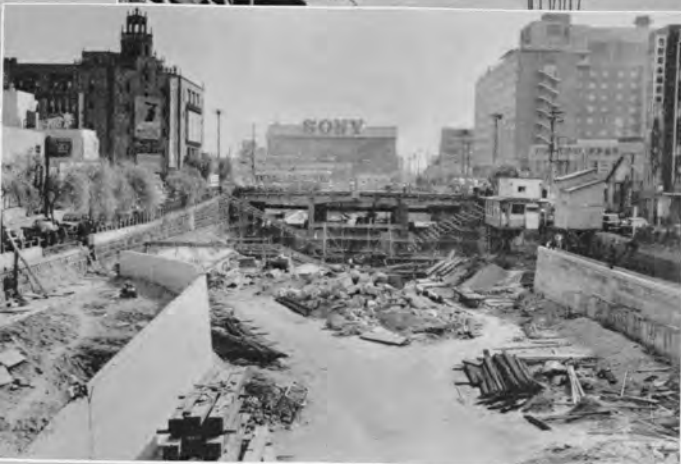
↑築地川工事現場 (1号線)
