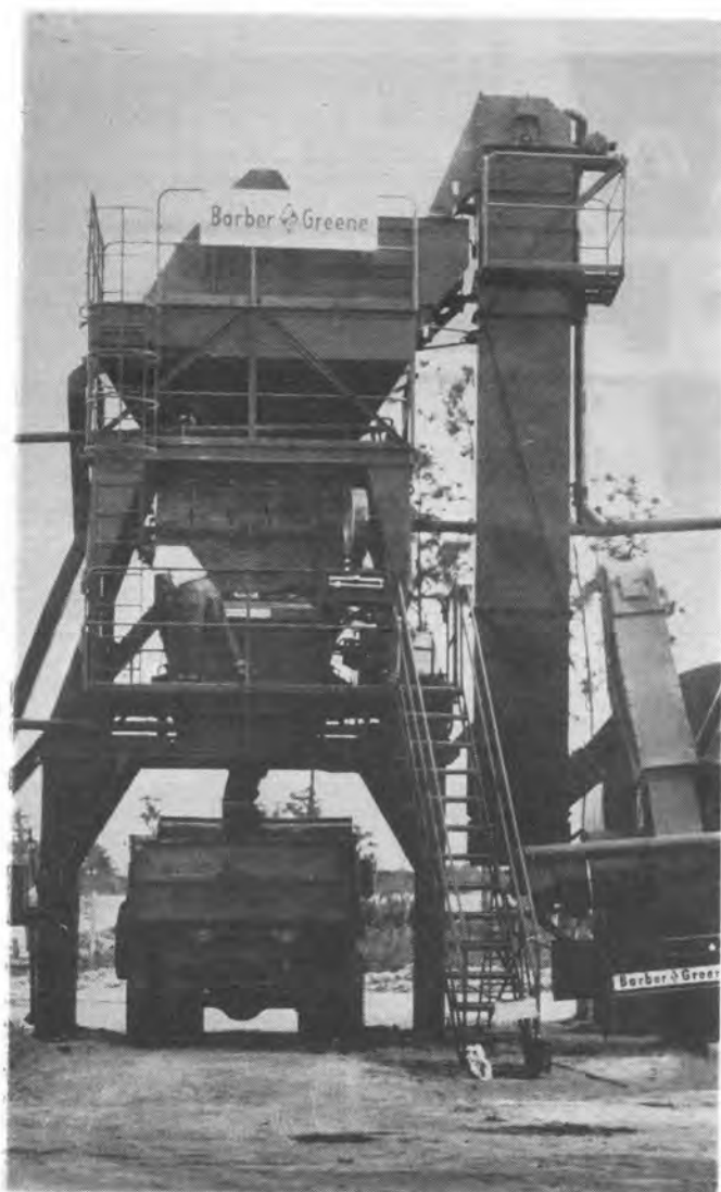
稼動中のバーバー・グリーン バッチ・プラント 1000 封度と 1500 封度の二種類があり 夫々最新技術を取入れて居ます
