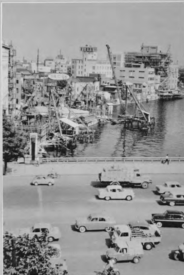
↑ 江戸橋インターチェンジ付近—1、4、6号線がこゝで合流する
