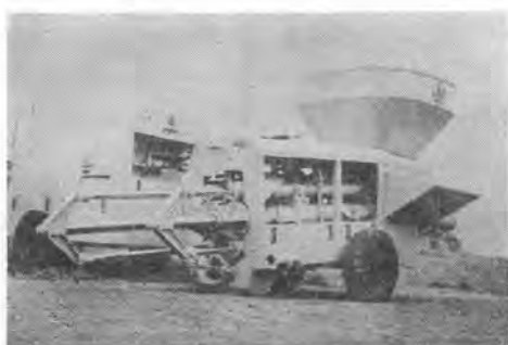
写真-6 右 コンクリートポンプ, 左 油圧装置
