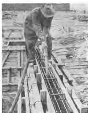
写真-10 ブレーサによる擁壁コンクリート工事
