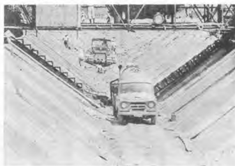
写真一5 開水路の薄いライニング工事 コンクリートをダンプトラックで運びスロープフォームで打設する
