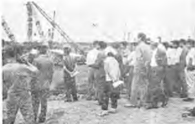
写真-1 苫小牧工業港作業現場
