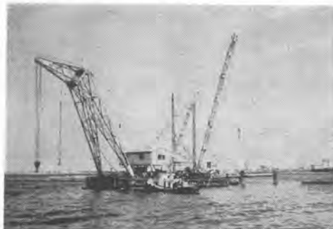
写真-3 はぎま 118号 40t固定ジブクレーン船
