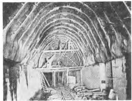
写真-4 アーチ部補強吹付け
