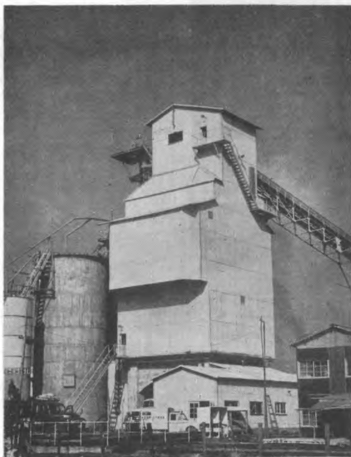
56切〜2型 全自動電子管式パッチャープラント
