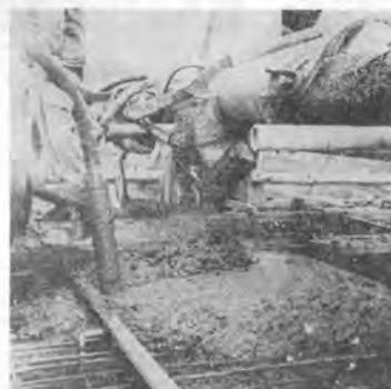
写真-9 フランクフルト道路橋工事—輸送管の途中でコンクリートを取り出す
