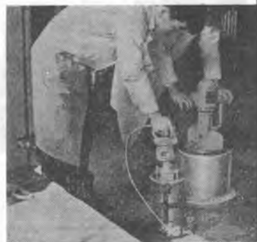
両機の振動作業中
