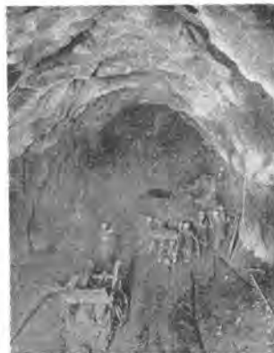
写真-2 堅岩ずい道のはだ落防止の吹付け
