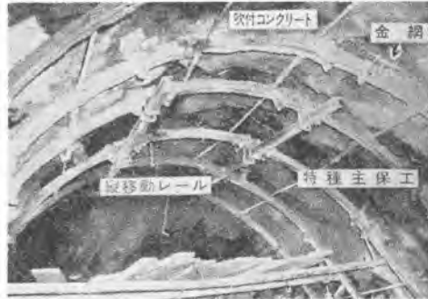
写真-5 アーチ部の補強吹付け-場所により金網を入れる場合もある
