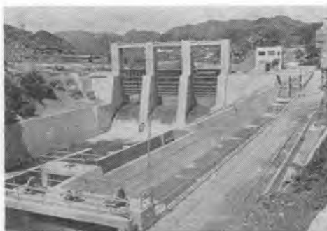
写真一2 完成した大野頭首工
