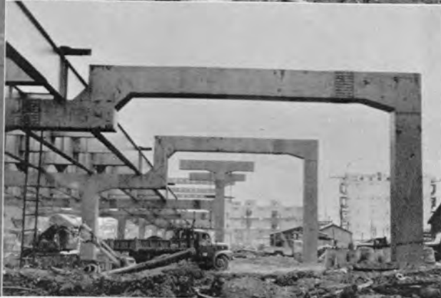
↑ 線形、交差、ランプの取付け等の関係で 橋脚はこのように奇妙な形をしている
