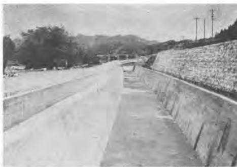
写真一4 大野開水路(下流側から)
