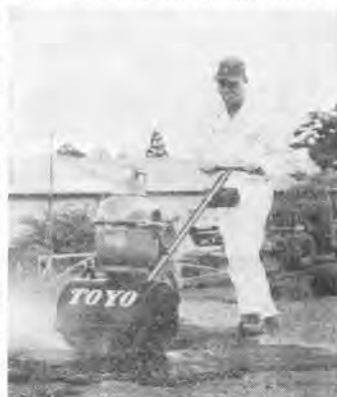
写真-3 アスファルトホットローラ
