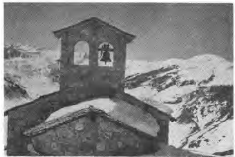
写真-6 アルプス連山に築堤中のローズランダム (右側にタワークレンおよび堤体の一部が見える。手前は廃屋となった鐘つき小屋)
