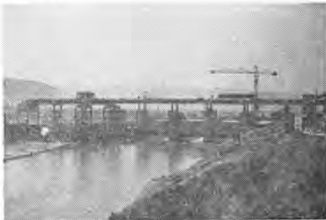
写真-8 エスカール頭首工(オレゾン発電工事)
