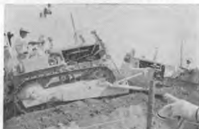
写真4 重機実演情況
