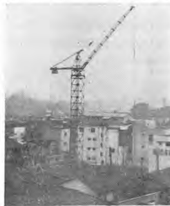
写真-1 高層建築に活躍するタワークレーン
