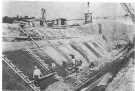
写真-2 打設開始—左側は平直し中
