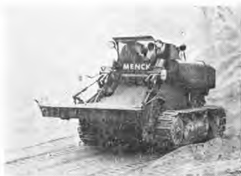
写真-1 神戸市・鶴甲山で作業中のスクレープドーザ
