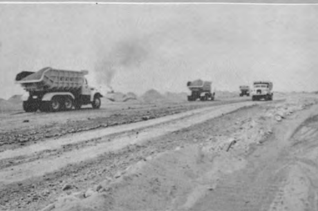
↑ストックパイルから埋立現場へ土砂運搬
