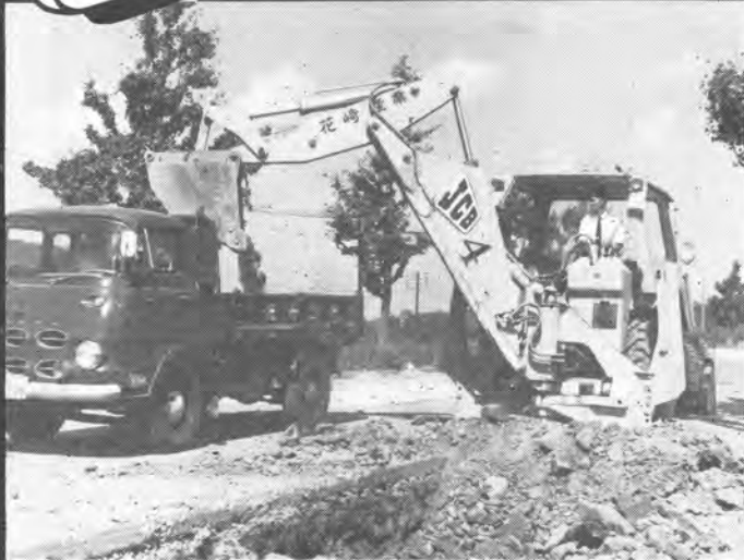
水道管敷設工事に活躍中の JCB-4 (花崎産業殿納入)
