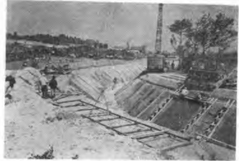
写真-5 打設を終了したスロープフォームが巻上台車に乗ったところ
