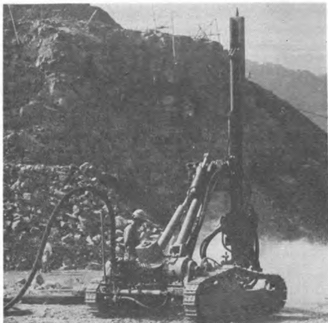
牧尾ダム工事現場
