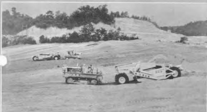
↑鶴甲山におけるスクレーバによる掘削集土作業
