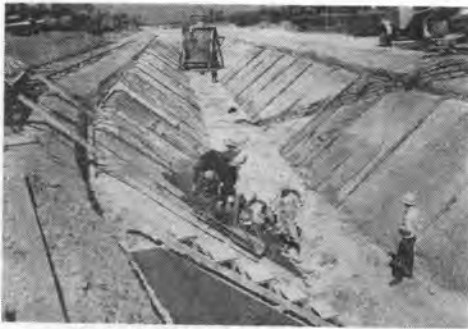
写真-3 稼働中のスロープフォーム
