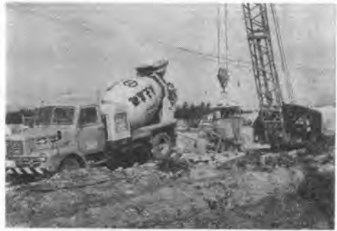
写真-1 バケツのコンクリートを打設位置に運搬するクローラクレーン 使用機械 アジテータトラックいすゞ 6.8t アジテータ 2.25 m 3 クローラクレーン 日立 U06 0.6 m 3 ブーム長さ 15 m
