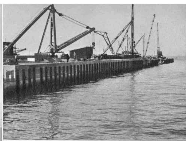
↑一部完成し既に荷役を行なっているセル型岸壁。
