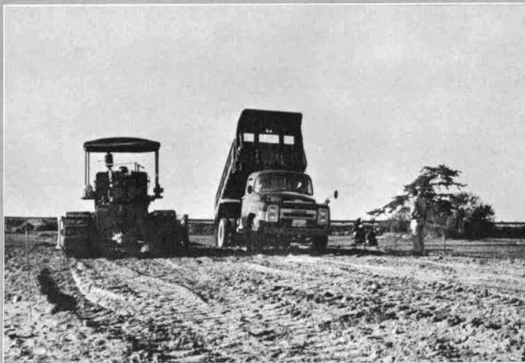
← 2級国道 127号線の改良工事。
