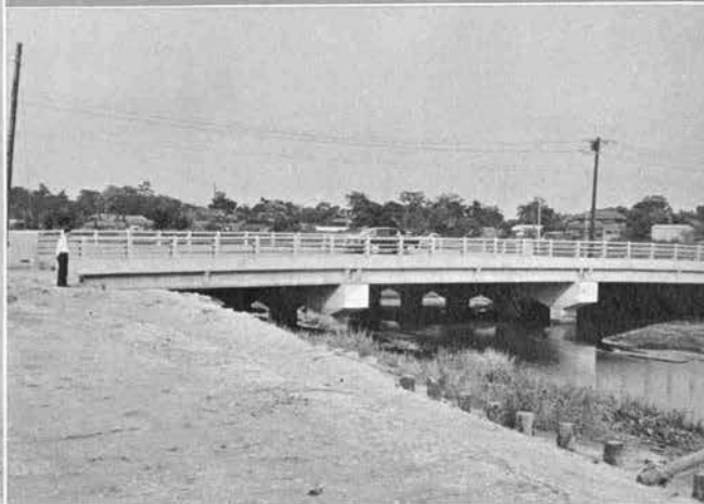
↑下部構造をベント、上部構造をP.C. けたで突貫工事で施工した。
